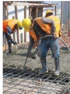
36 Imagen de un armado para losa maciza
