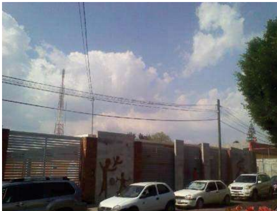
FACHADA DE ACCESO ACTUAL FIG. # 12
