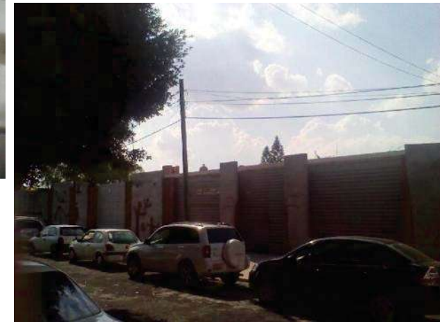
FACHADA DE ACCESO ACTUAL FIG. # 14
