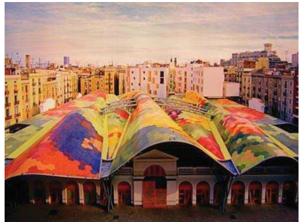
Fig.28: Remodelación del mercado Santa Caterina en Barcelona, obra de Enric Miralles donde se muestra claramente como la obra se adapta con el entorno que lo rodea/fotografía de Toni Cumella.
