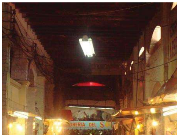
Fig.8: Techumbre en mal estado lo que genera humedad y riesgos de enfermedades por la acumulación de suciedad.
