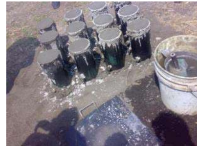
Fig.54: Control de calidad del concreto.
