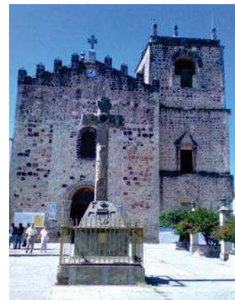
Fig.46: Fachada principal de la Parroquia de San José.
