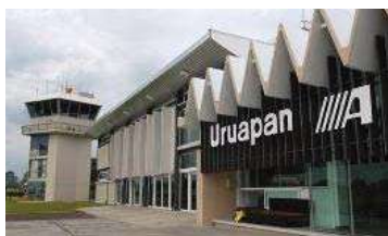
IM12 Fachada del Aeropuerto de Uruapan Michoacán. [ http://www.aeropuertosdelmundo.com.ar/america/norte/mexico/aeropuertos/uruapan.php ]
