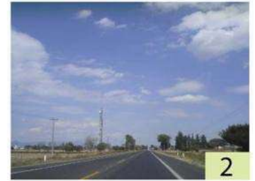
Carretera federal "Morelia-Aeropuerto"
