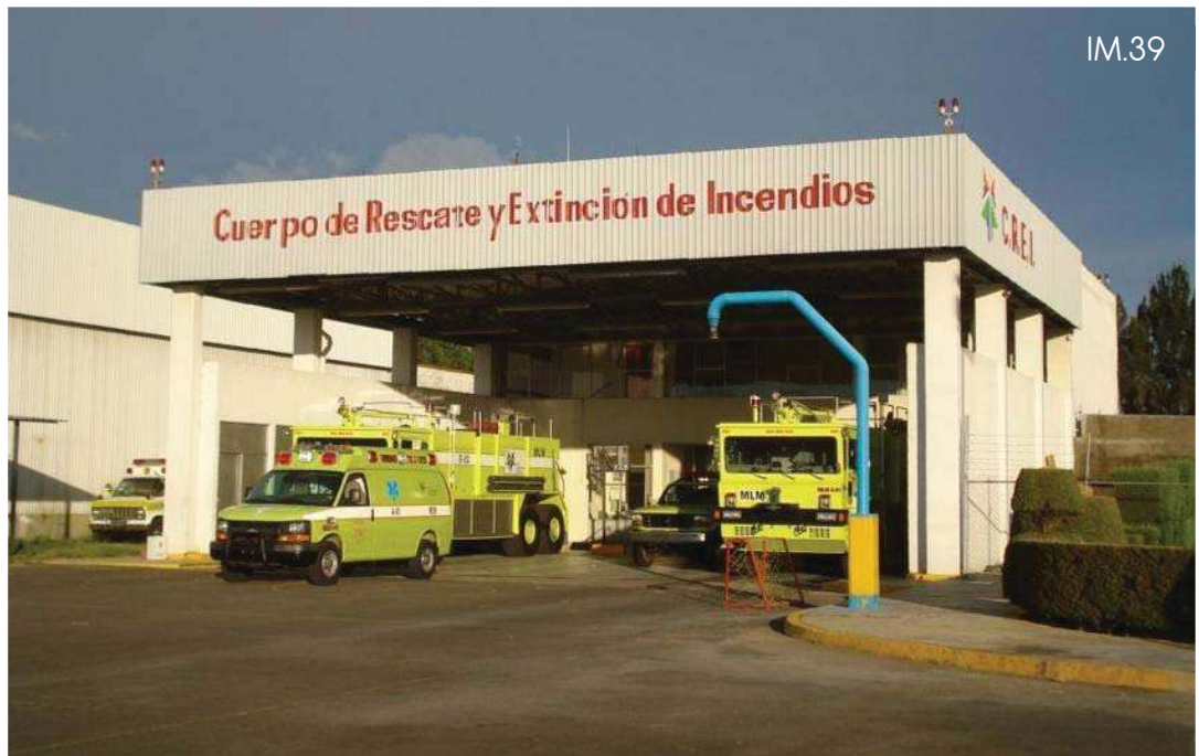
IM39: Imagen de las instalaciones del cuerpo de rescate del Aeropuerto de Morelia. [CADRN]
