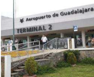
IM68: Fachada principal del estacionamiento de la Terminal 2 del Aeropuerto de Guadalajara "Miguel Hidalgo y costilla". [ http://aeropuertosgap.com.mx/aeropuertos/Guadalajara ]
