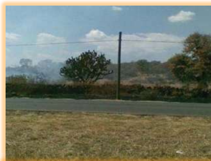
Imagen 39, Ubicación de postes de teléfono Fuente: J.C. García S. (20/04/11, 3:43 pm).
