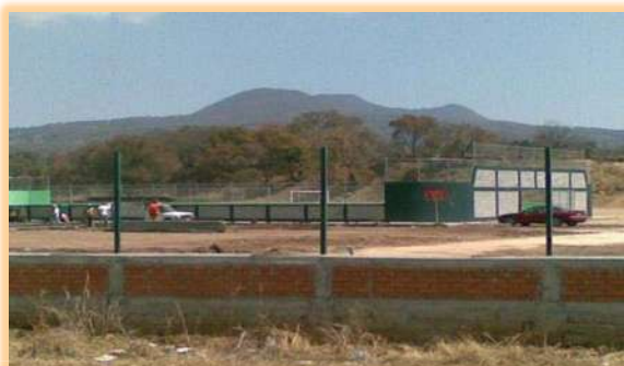
Imagen 33, Unidad deportiva "cuto de la esperanza" que colinda con el terreno. Fuente: J.C. García S. (20/04/11, 2:52 pm)
