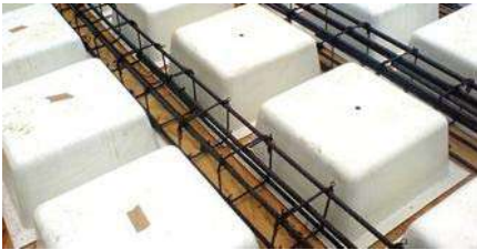
IMAGEN 6.2 SISTEMA TERNIUM PANEL AISLADO PARA AZOTEA
