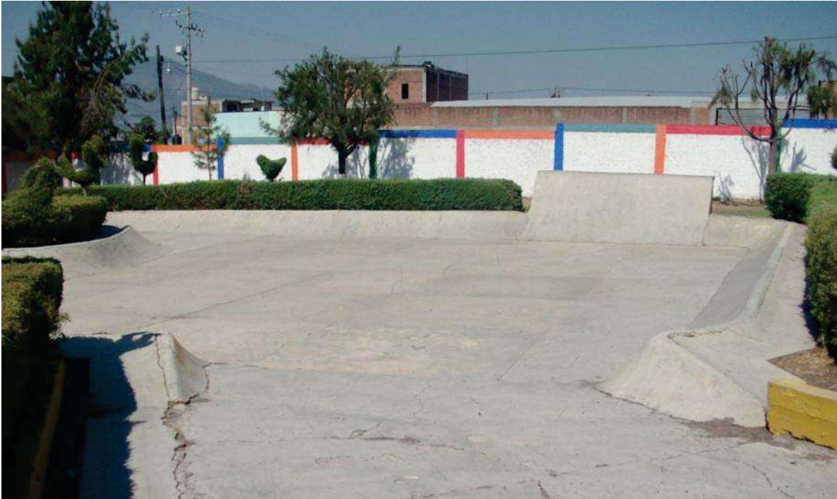
Ilustración 21.- Rampa de Acceso a Pista de Patinaje de Concreto.
