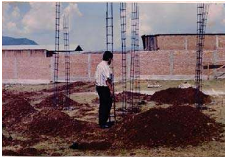
SUPERVISION DE CIMENTACION EN SANITARIOS.
