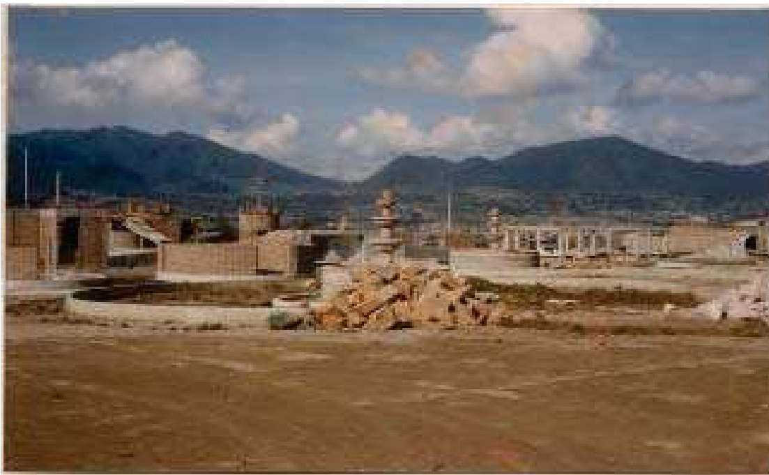
Ilustración 11.- fotografía tomada al inicio de la construcción del parque recreativo infantil
