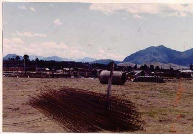
VISTA PARCIAL DE LA CONSTRUCCION DE RESBALADILLAS DE CONCRETO.
