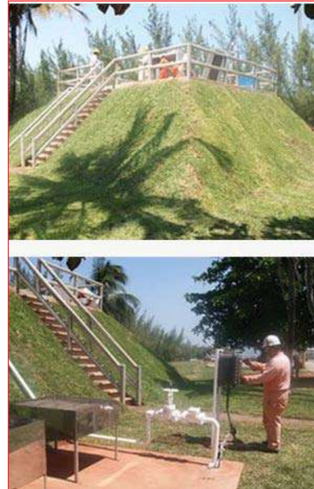
Imagen 23: Planta tratadora de aguas en funcionamiento por gravedad. Fuente: http://www.cbringenieria.com.mx/compacta.html .
