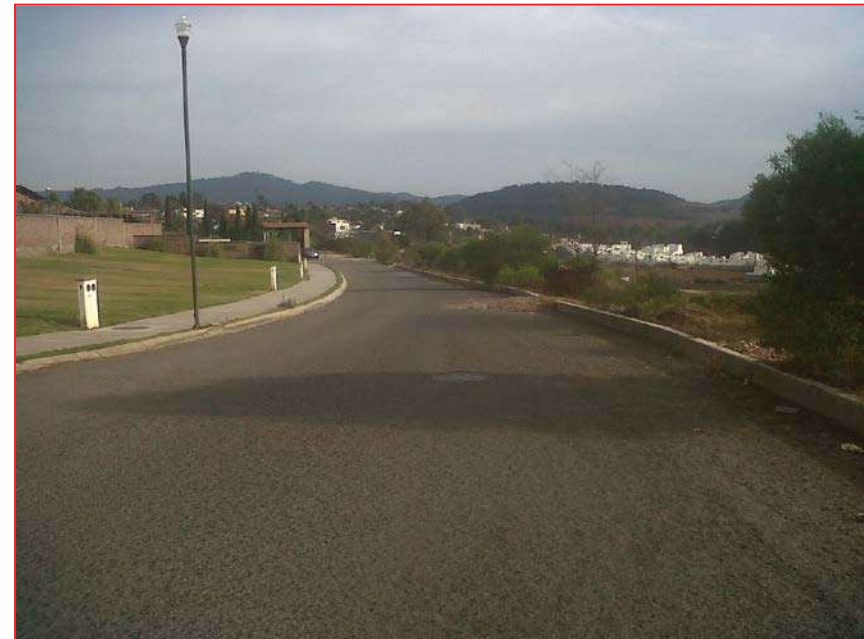
Imagen 28: Como se puede observar en el frente del terreno están las líneas de electrificación, las líneas de drenaje y agua potable.
