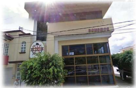
FOTOGRAFÍA No. 7: FACHADA NORTE DE ESTACIÓN DE BOMBEROS LATINOAMERICANA EN URUAPAN, MICH.
