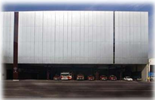
FOTOGRAFÍA No. 8: FACHADA PPAL. DE ESTACIÓN DE BOMBEROS “AVE FÉNIX” EN MÉXICO DISTRITO FEDERAL.
