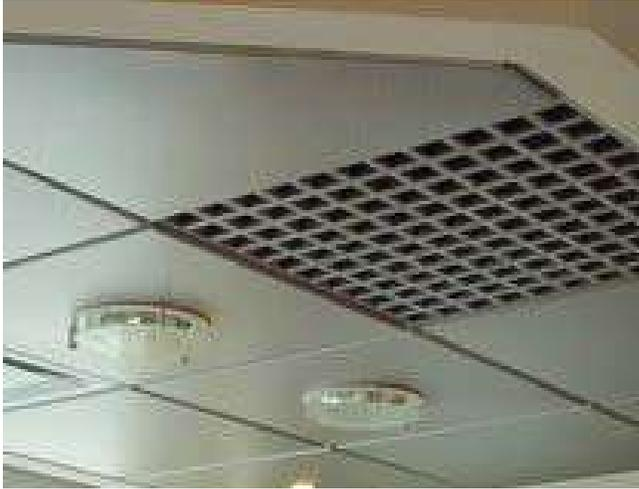
El plafón Cell T-15, es abierto y transparente compuesto por perfiles derechos e izquierdos y un fleje perimetral formando una grilla cuadrada.
