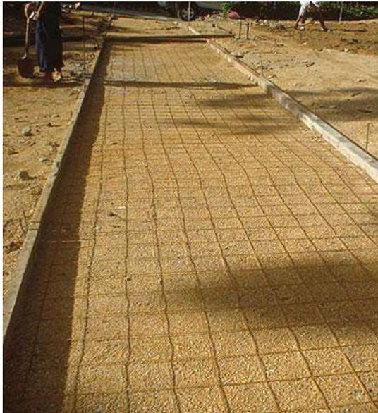
Es un producto formado por dos sistemas de elementos (barras o alambres), uno longitudinal y otro transversal, que se cruzan entre sí perpendicularmente y cuyos puntos de contacto están unidos, mediante soldaduras eléctricas, por un proceso de producción en serie, en instalación fija.
