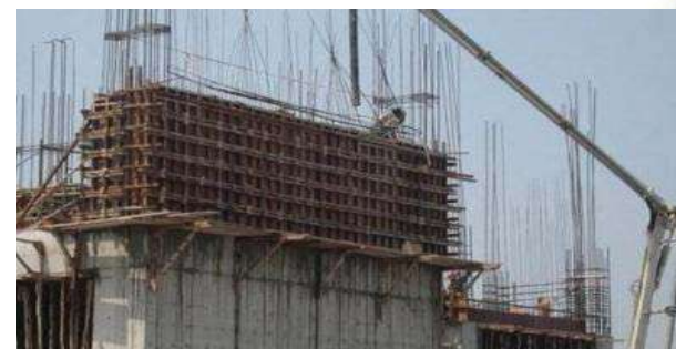
Muro de Concreto Armado Diciembre.2010 Skyscraper 2000 http://www.skyscrapercity.com/gallery
