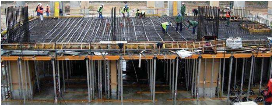
Armado De Loza Maciza Diciembre.2011 ULMA Const. 2010, http://www.google.com.mx/imgres?q=losa+maciza
