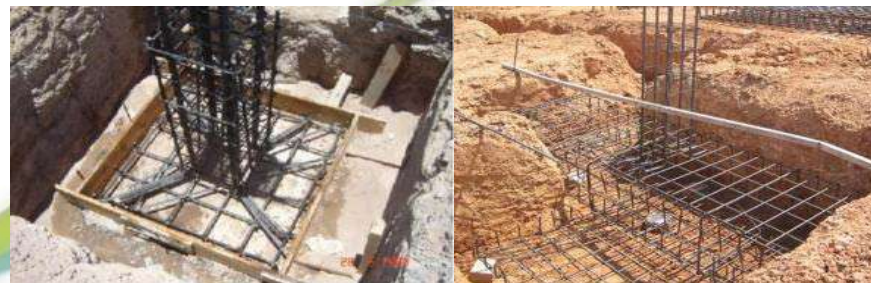
Armado De Una Zapata
