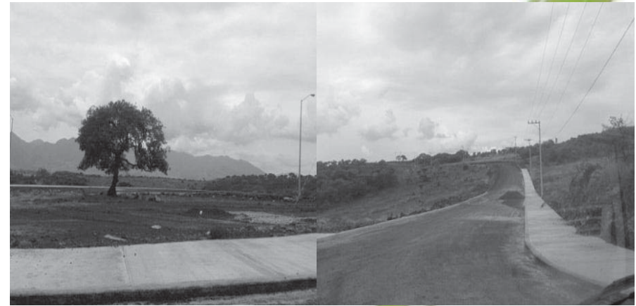
Vistas 1-Norte Acceso
