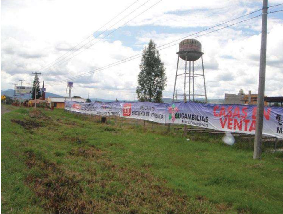
Foto 13. Frente del fraccionamiento Buganvilias, se puede apreciar el desnivel con respecto a la carretera. Este fraccionamiento es el mas próximo al terreno propuesto. Autor: Oliva López, J. G.
