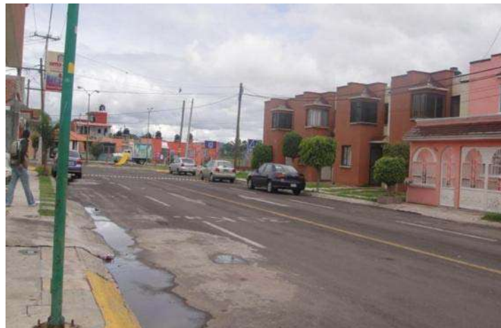
Foto 17. Fraccionamiento Rinconada Los Sauces, vista exterior. Foto: Jonathan Gonzalo Oliva López, fecha: septiembre de 2010.
