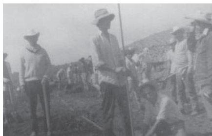
39/Trabajos para la construcción la carretera/ Archivo del comisariado de bienes comunales de San Andrés, Tziróndaro / 2009
