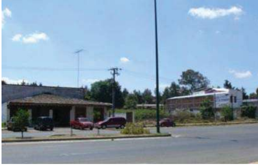
Imagen 9.12. Vista de oficinas ubicadas en la parte frontal del terreno, propuesta 3.
