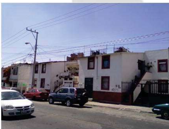
"Condominios habitacionales" FOTO: EAJJ, 2011
