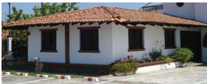
Imágenes de cubiertas inclinada de teja de barro. Características de la región.
