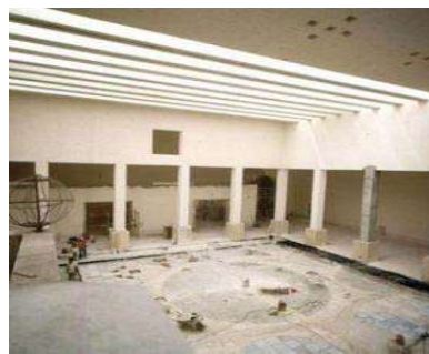
Etapa de construcción del patio central.
