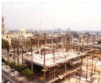
Etapa de construcción del museo.
