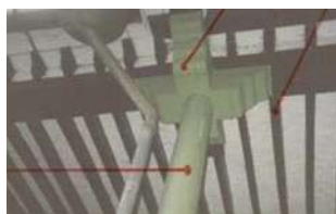
Detalle de la estructura de la cubierta
