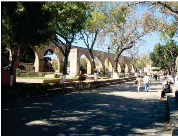
Imagen 11. Vista lateral desde la Calzada, se observa el Acueducto en su tramo medio.)
