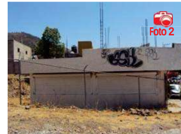
Fig. 204 Fachada principal, Foto: AMT
