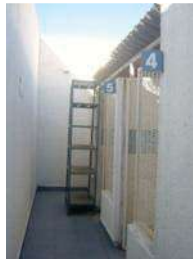
Fig. 147 Jaulas de hospitalización diurna, Espacio que actualmente en una parte alberga equipo de gas médico, entre otros, Foto: AMT
