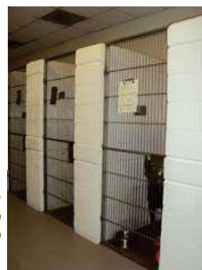
Fig. 165 Hospitalización para perros, Jaulas hechas en obra con reja de acero cuya mayor deficiencia es no contar con iluminación y ventilación natural suficiente, Foto: AMT
