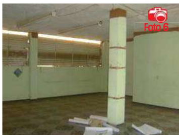
Fig. 208 Vista interior hacia ventanas laterales de fachada oeste. Foto: AMT
