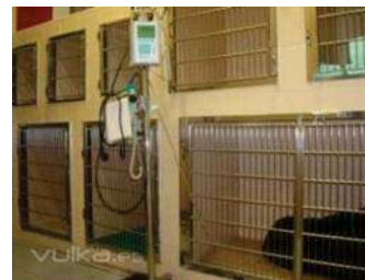
Fig. 19 Vaulas de hospitalización, vaulas elaboradas en obra con puerta de acero inoxidable que permite la ventilación y cuya mayor ventaja es el soporte de los materiales, En: [http://galeria.vulka.es]
