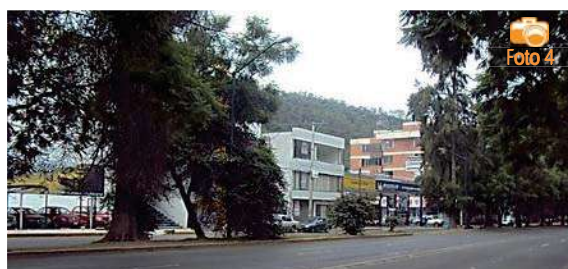
Fig. 119 Vista hacia el frente de la clínica, avenida Camelinas, Foto: AMT
