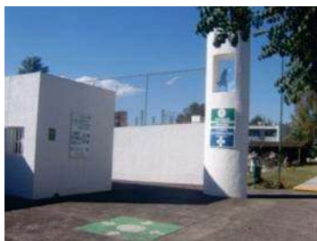
Fig. 64 Edificio de la clínica veterinaria de la FMVZ, Foto: AMT
