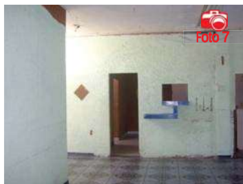
Fig. 209 Muro interno y acceso que comunica a los locales, Foto: AMT
