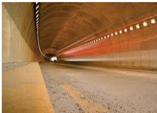
84. Distribuidor Vial Salida a Charo, en Morelia, Michoacán. Parte de la infraestructura de la ciudad.
