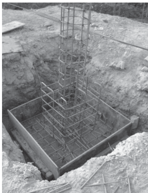
36. Zapatas aisladas para columnas centrales del edificio
