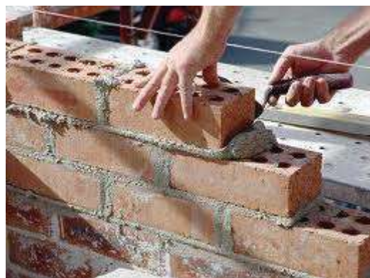
102. Colocación de tabiques con mortero.
