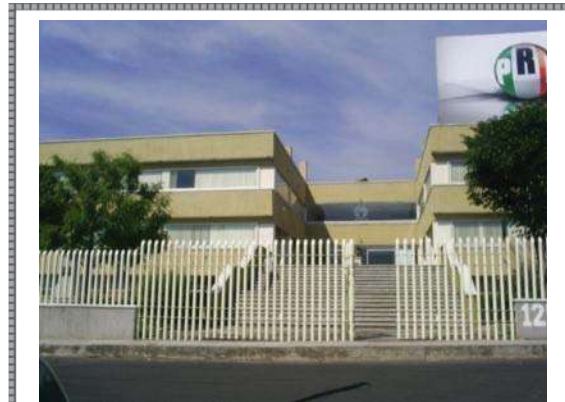
Imagen 3.16 Vista de barrera y falta de rampas en oficinas Fuente: propia
