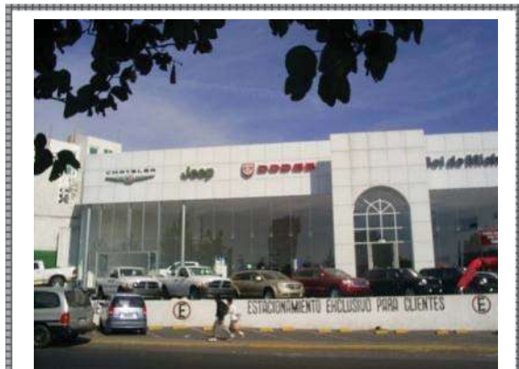
Imagen 3.19 Vista de estacionamiento sobre línea visual Fuente: propia
