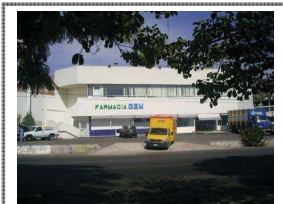
Imagen 3.18 Vista de rampa sobre la banqueta Fuente: propia
