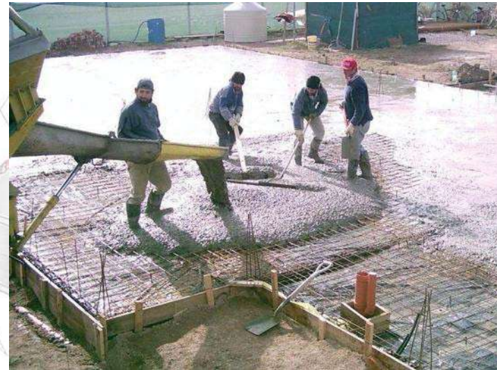
149.- EJECUCIÓN DE UNA LOSA DE CIMENTACIÓN.
