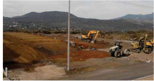
Foto 29, Plataformas y compactación de terreno, foto RMH.
