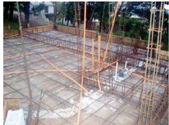
Imagen 31, Entubado eléctrico antes de colar pisos y castillos, http://www.arquitectosyconstructores.com/rvaliente/armadolosas.htm
