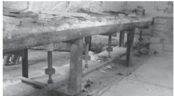
Foto 8, Instalación de Gas para el horno, Foto RMH.
