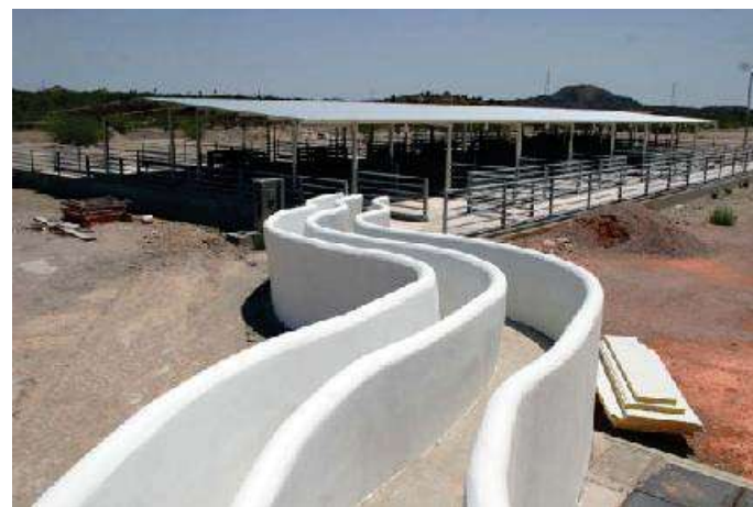
IMAGEN 59 Establos de Observacion/foto Edwin Flores
