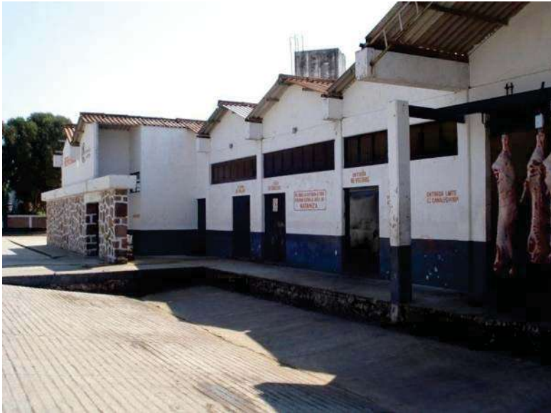
IMAGEN 19 Fachada del área de matadero /foto Edwin Flores
