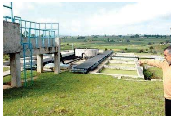
IMAGEN 75 Planta tratadora de Aguas Residuale/Foto Edwin flores
