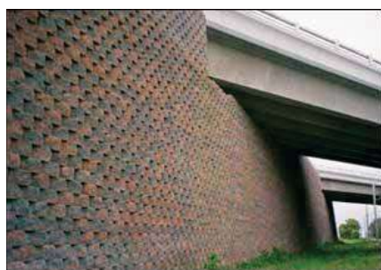
I-09 Fotografías de uso de material en muros de contención para soporte de puente vial, archivo de empresa KEYSTONE. 57
