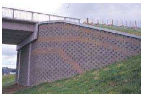
I-09 Fotografías de uso de material en muros de contención para soporte de puente vial, archivo de empresa KEYSTONE. 57
