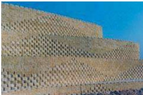
I-13 Imágenes de usos de sistema KEYSTONE en contención material del terreno de Centro Deportivo.
