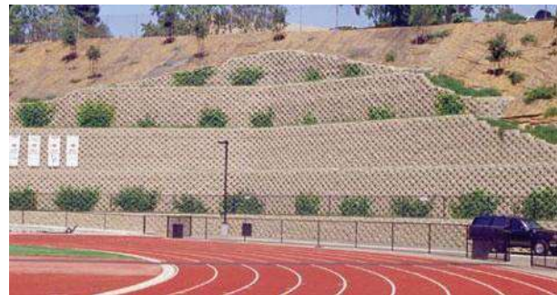
I-13 Imágenes de usos de sistema KEYSTONE en contención material del terreno de Centro Deportivo.
