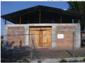
Figura 1.52 Vista de Capilla La Natividad Fuente: Autoras
