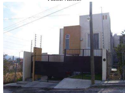
Figura 1.66 Vista de la vivienda Unifamiliar “Barrio 4” Fuente: Autoras
