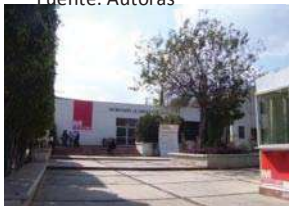
Figura 1.54 Vista de H. Ayuntamiento Obras Fuente: Autoras
