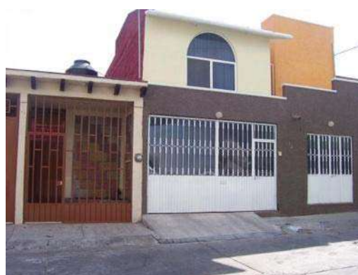
Figura 1.68 Vista de la vivienda unifamiliar “Barrio 5” Fuente: Autoras
