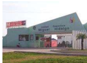
Figura 1.50 Vista del Deportivo Miguel Hidalgo Fuente: autoras
