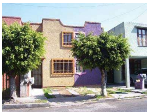
Figura 1.69 Vista de la vivienda unifamiliar “Barrio 6” Fuente: Autoras
