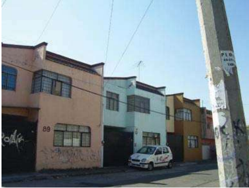
Figura 1.61 Vista de la vivienda unifamiliar “Barrio 1” Fuente: Autoras
