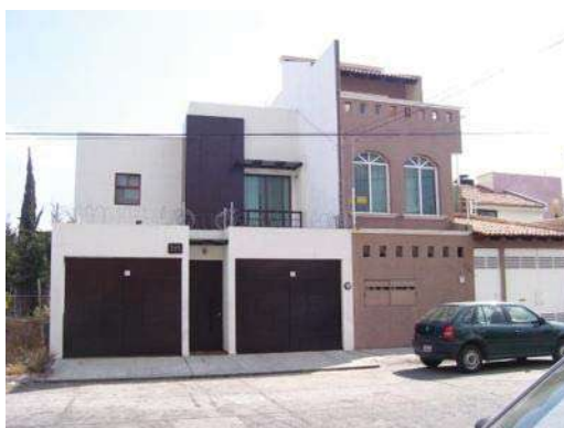
Figura 1.67 Vista de la vivienda unifamiliar “Barrio 5” Fuente: Autoras
