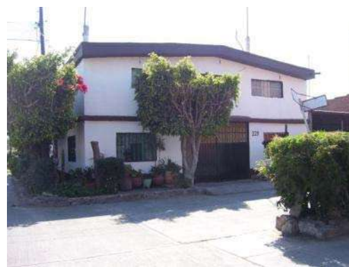
Figura 1.70 Vista de la vivienda unifamiliar “Barrio 6” Fuente: Autoras
