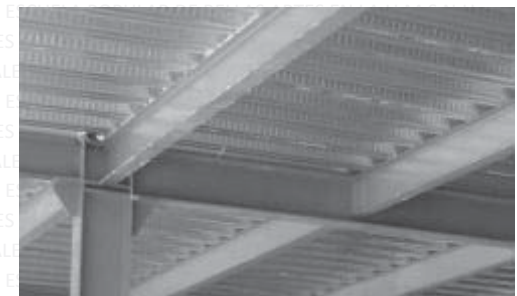
69.- TRABES IPR, UNIDAS A COLUMNAS Y VIGAS SECUNDARIAS UNIDAS A TRABES.
