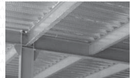
95.- TRAVES IPR, UNIDAS A COLUMNAS Y VIGAS SECUNDARIAS UNIDAS A TRAVES.
