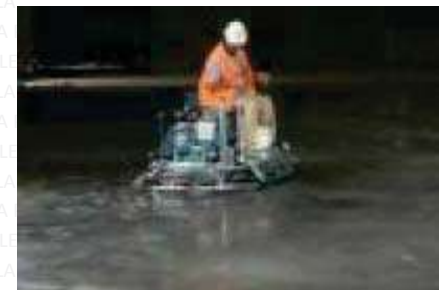
83.- VACIADO PULIDO DEL CONCRETO.
