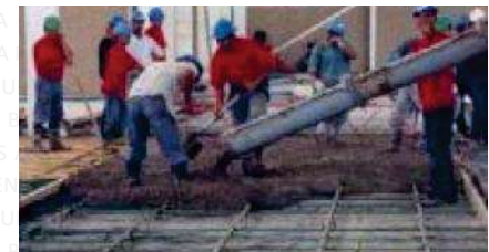
81.- VACIADO DEL CONCRETO.
