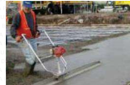
82.- VIBRADO DEL CONCRETO.
