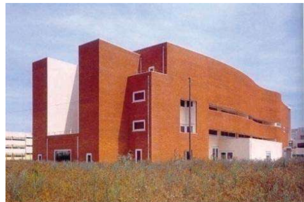
Img. 08 Alvaro Siza, Biblioteca, Universidad de Aveiro. al. , El regionalismo Crítico , Material didáctico, Teoría de la Arquitectura Contemporánea.
