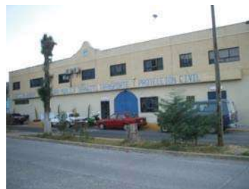
PR-01_09-10 Como parte del Equipamiento también se encuentra la dirección de policía y tránsito.
