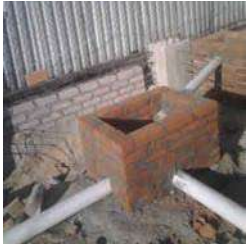
Img. 91-92. Colocación de drenajes (Inst. Sanitaria). Fuente: http://www.sistemasconstructivos.com/ Abril 2009.
