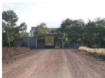
PR-02_01 Acceso de la Escuela como parte del equipamiento de la zona, se ubica frente al terreno.
