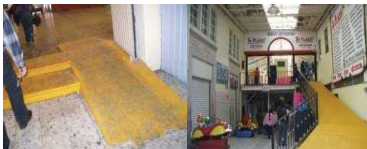
Img. 52. Existen rampas para minusválidos. Fuente: Fotografía por autor.
