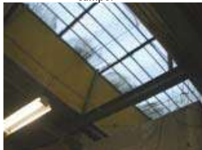
Img. 41-42 Iluminación natural. Fuente: Fotografías por autor.
