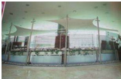
Img. 100. Imagen de tensoestructura, donde se aprecia los tensores. Fuente: Ibidem
