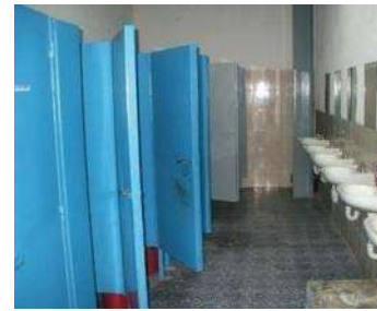
Img. 45. Módulo de sanitarios para mujeres. Fuente: Ibidem.
