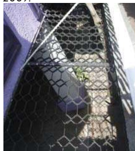
Img. 104. Rejillas de herrería. Fuente: Imágenes recopiladas por autor.
