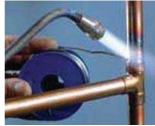
Img. 93. Soldadura de tuberías hidráulicas. Fuente: http://www.simasa.com.mx , Abril 2009
