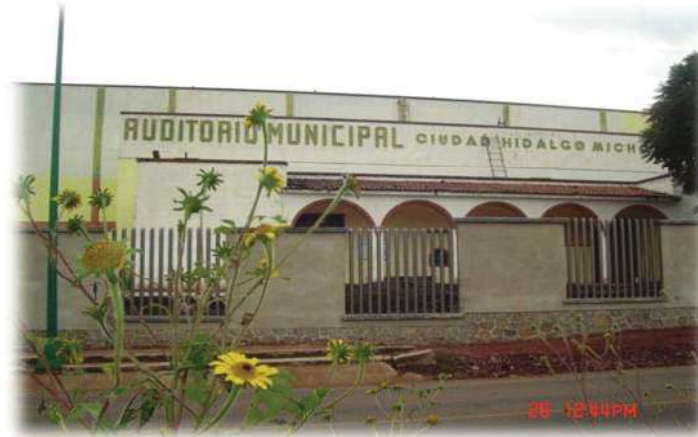
Fig. 16. Acceso principal al auditorio Municipal de Ciudad Hidalgo.
