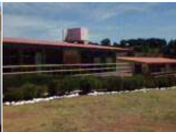
20: Imagen de la fachada sur, MNM
