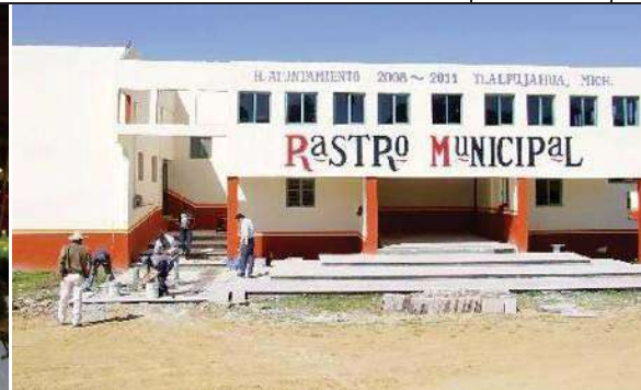
24: Imagen de la fachada principal del rastro municipal de Tlalpujahua
