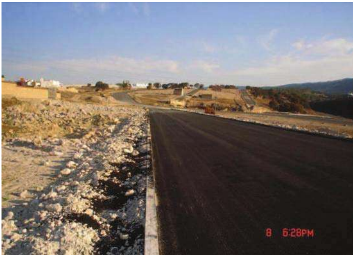
5.- Vialidades de acceso para el terreno ya pavimentadas
