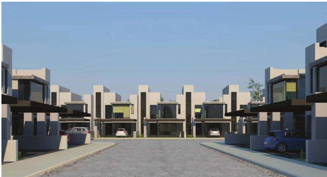
FOTO No. 10.- VISTA FRONTAL EN CONJUNTO DE FRACCIONAMIENTO.
