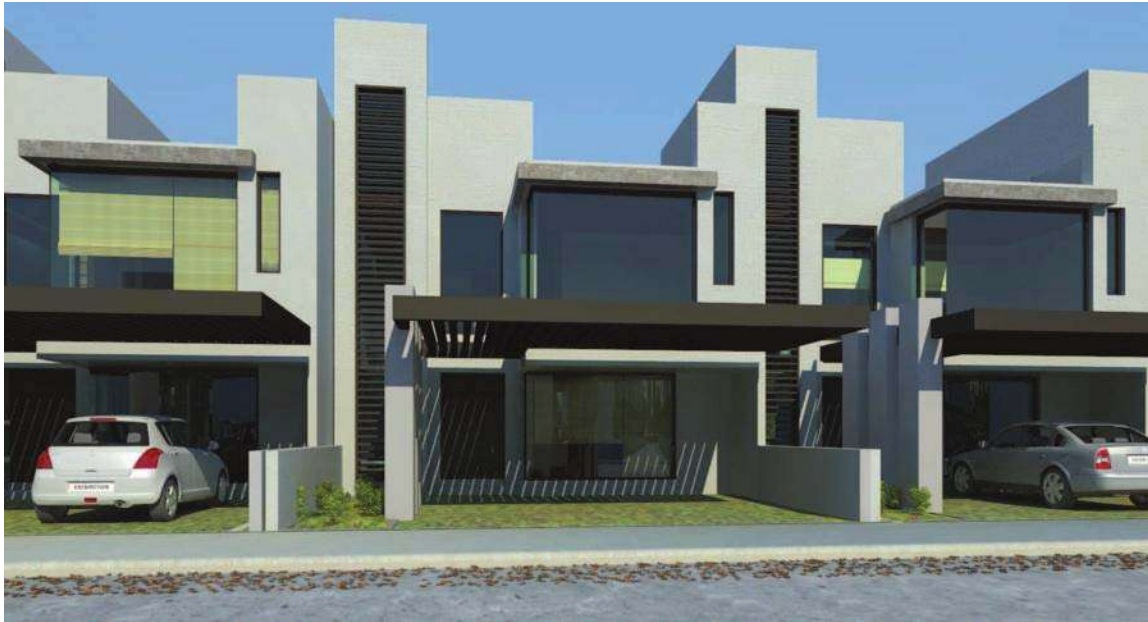
FOTO No. 13 VISTA FRONTAL DE CASA HABITACION.
