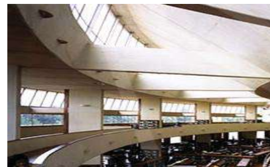
Foto 17. Perspectiva interior, se muestran los apoyos y vigas principales alineados en forma semicircular.
