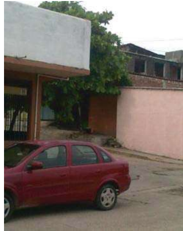
Foto 30. Se muestra casas habitacionales. Fuente: Tomada por Fredy Martínez Navarrete
