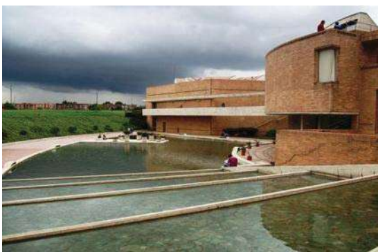
Foto 12. Perspectiva, se muestra la fachada del edificio cubierta de ladrillo y al lado espejos de agua o canales en forma de cascada.
