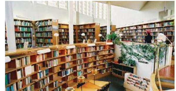
Foto 8. Perspectiva interior, muestra columnas redondas que sostiene el cielo raso interior del área de estantería. Fuente: Alvar Aalto Obras y Proyectos
