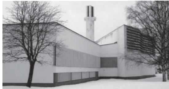
Foto 2. Perspectiva, se muestran barras metálicas verticales en las ventanas de las oficinas la cual se integra con el paisaje.
