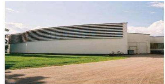
Foto 4. Perspectiva, se muestra grandes barras de aluminio en la parte superior de la forma del abanico del edificio, el cual permite el control solar al interior de la Biblioteca.
