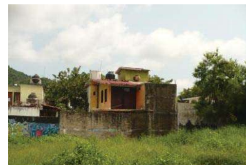
Foto 44 . Se observa la barda de una construcción (casa habitación) Fuente: Tomada por Fredy Martínez Navarrete
