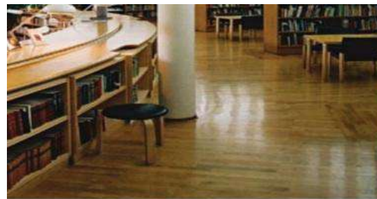
Foto 6. Área de Estanterías, muestra el acabado final del piso, el cual esta hecho por madera plastificado.
