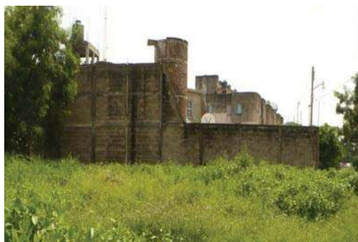
Foto 41. Se observa la barda de de una construcción (casa habitación) Fuente: Tomada por Fredy Martínez Navarrete
