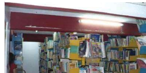
Foto 21. Perspectiva interior se muestran traveses en la parte inferior del entrepiso ubicadas en sentido transversal.
