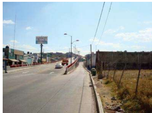
Fig. 50 Puente Vehicular Gpe Victoria-T. Nuevo. Fuente: Autor
