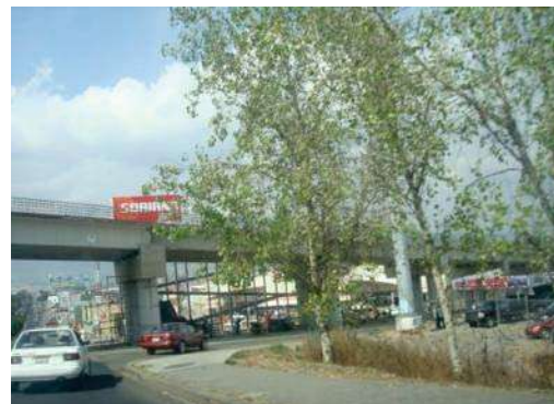
Fig. 51 Puente Vehicular Gpe Victoria – T. Nuevo. Fuente: Autor
