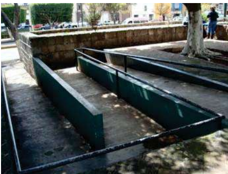
Fig. 22 Rampa discapacitados. Fuente: Autor.
