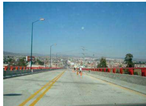
Fig. 52 Puente Vehicular Gpe Victoria – T. Nuevo. Fuente: Autor
