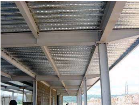
Fig. 65 Estructura de Acero. Fuente: Autor.
