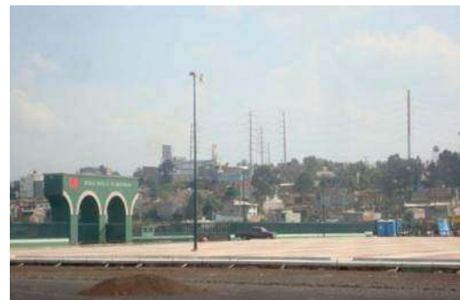
Fig. 56 Explanada de Usos Múltiples. Fuente: Autor.
