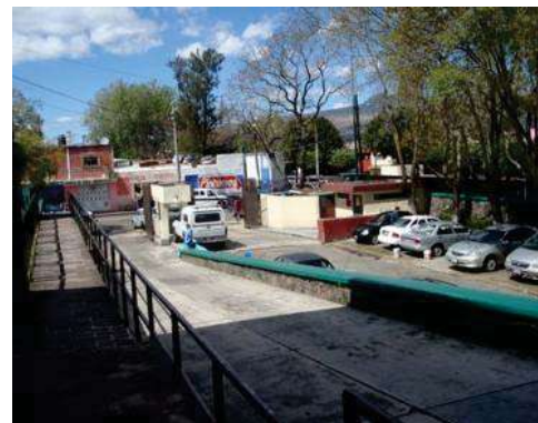
Fig. 32. Acceso Ambulancias. Fuente: Autor
