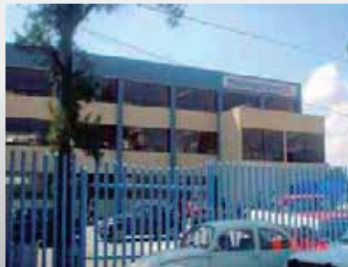
(50) Fachada de la Escuela Preparatoria ICA, localizada en Av. Universidad
