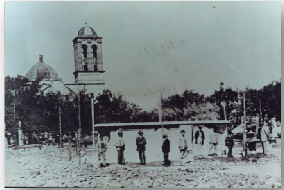
IMAGEN 9. Construcción del kiosco a principios del siglo XX. Fuente: J. Antonio Zavala Bucio, cronista de la ciudad.
