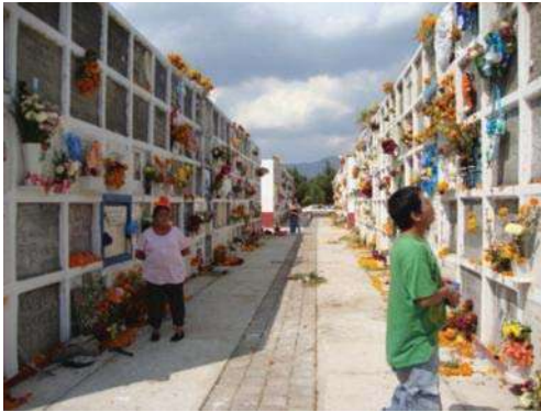
Imagen 4.13.- Vista del estado actual de los Módulos de Gavetas de El Vergel
