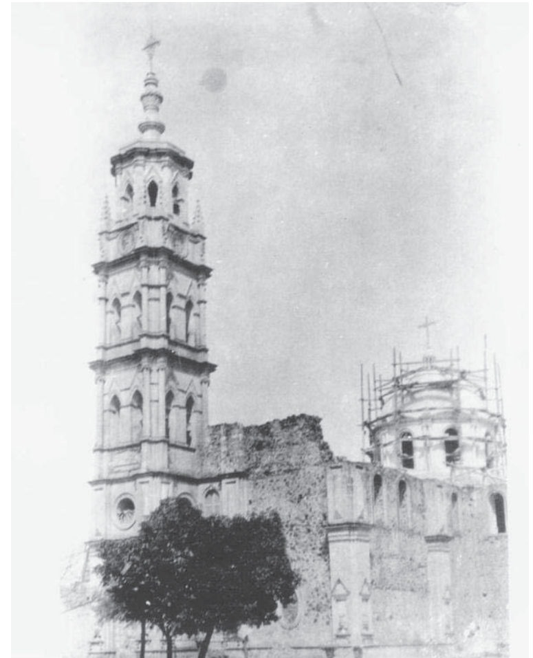
Ilustración 40 ACTUAL TEMPLO DEL SEÑOR DE LA DIVINA CLEMENCIA, DURANTE SU CONSTRUCCIÓN HACIA 1910
