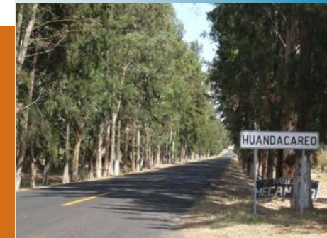
FALTA DE SEÑALAMIENTOS ACCESO PRINCIPAL CARR. HUANDACAREO - CUITZEO
