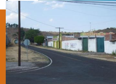
FALTA DE SEÑALAMIENTOS ACCESO PRINCIPAL CARR. HUANDACAREO - MORELON
