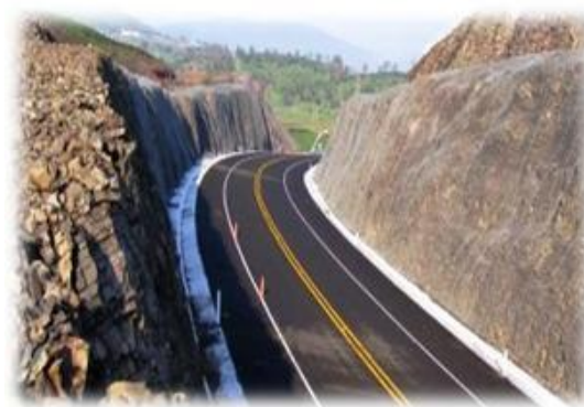
IMAGEN 4. CAMINO EN PROCESO DE CONSTRUCCIÓN A CARGO DE LA SCOP, EN LÁZARO CÁRDENAS. MICHOACÁN.
