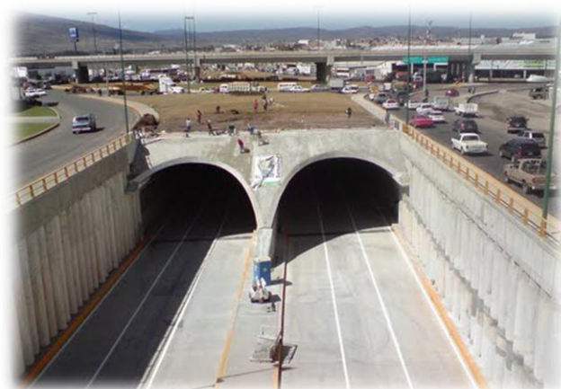
IMAGEN 44. PUENTE Y DISTRIBUIDOR VIAL DE SALIDA A CHARO.
