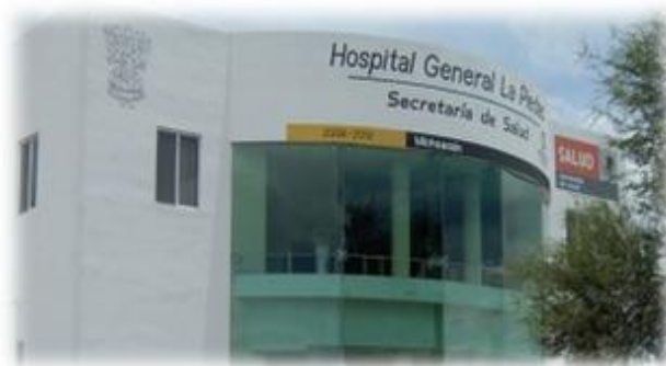
IMAGEN 10. HOSPITAL GENERAL LA PIEDAD. OBRA A INAGURARSE LLEVADA A CARGO DE LA SCOP.
