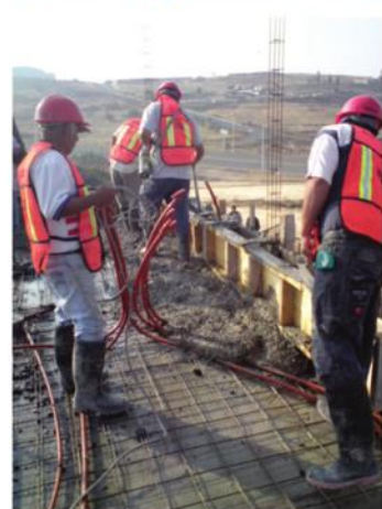
FIG. 135: VACIADO DE CONCRETO EN ENTREPISOS (ROBLE).
