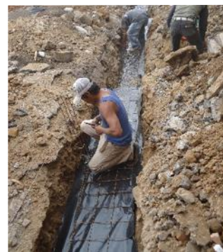
FIG. 149: ELABORACIÓN DE PLANTILLAS PARA RODAPIE EN PATIO (SAUCE).
