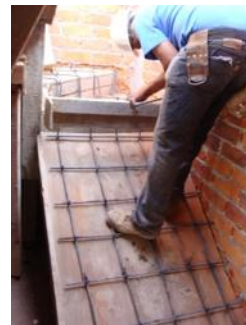
FIG. 146: CIMBRA Y ARMADO DE ESCALERAS (ROBLE).
