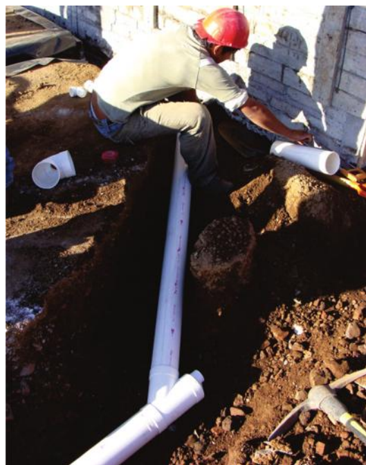
FIG. 78: FOTOS DE PVC Y SU COLOCACIÓN EN SEPAS. IMAGEN//GERARDO LUDWING ACUÑA CENOZ
