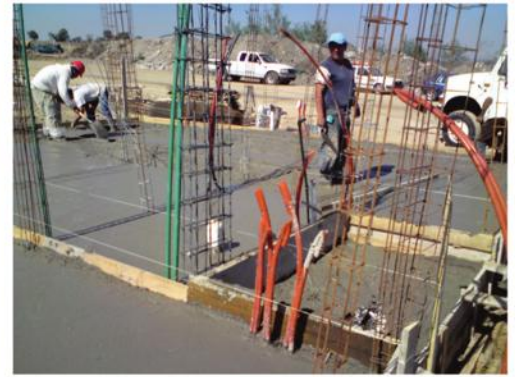
LOTE FIG.109: APLICACIÓN DE CONCRETO EN CIMENTACIÓN LOTES 1-2 (ROBLE).
