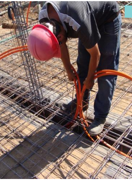
FIG. 103: COLOCACIÓN DE MANGUERA ELÉCTRICA EN LOTES ROBLE
