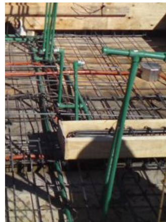
FIG. 130: INSTALACIÓN HIDRAULICA Y SANITARIA EN ENTREPISO (ROBLE).
