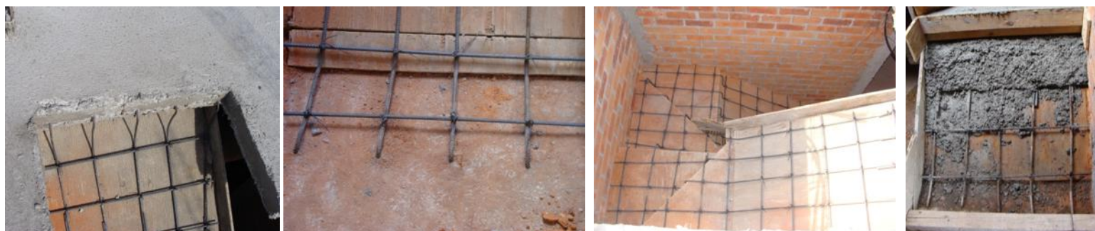
FIG. 147: VARILLAS PENDIENTES EN FIRME Y LOSA ARMADO Y COLADO DE ESCALERA (ROBLE). // FOTOS: GERARDO LUDWING ACUÑA CENOZ.
