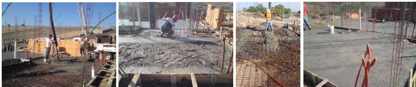
FIG. 115: CONCRETO EN PLATAFORMAS (CASTAÑO).
