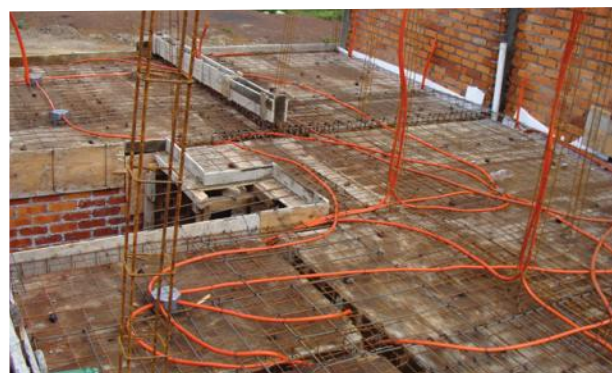
FIG. 56: FOTO LOSA DE ENTREPISO (ROBLE). IMAGEN// GERARDO LUDWING ACUÑA CENOZ
