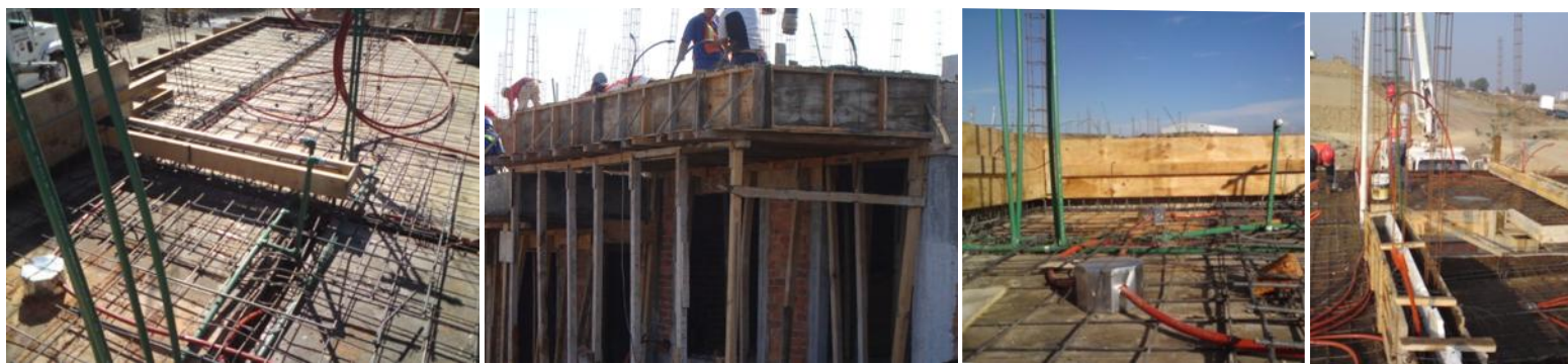
FIG. 131: DESPUÉS DE TAPONEAR LOS RAMALEOS SE ENCOFRARON LOS ELEMENTOS ESTRUCTURALES (ROBLE).
