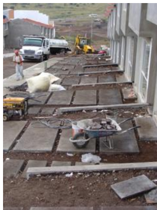
FIG. 45: PLANTA DE COCHERA (CASTAÑO) Y FOTO QUE MUESTRA LAS HUELLAS ELABORADAS. IMAGEN: TRES MARIAS // FOTO Y EDICIÓN: GERARDO LUDWING ACUÑA CENOZ.
