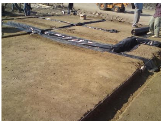
FIG. 94: MEMBRANA DE POLIETILENO EN CEPAS// FOTOS: GERARDO LUDWING ACUÑA CENOZ
