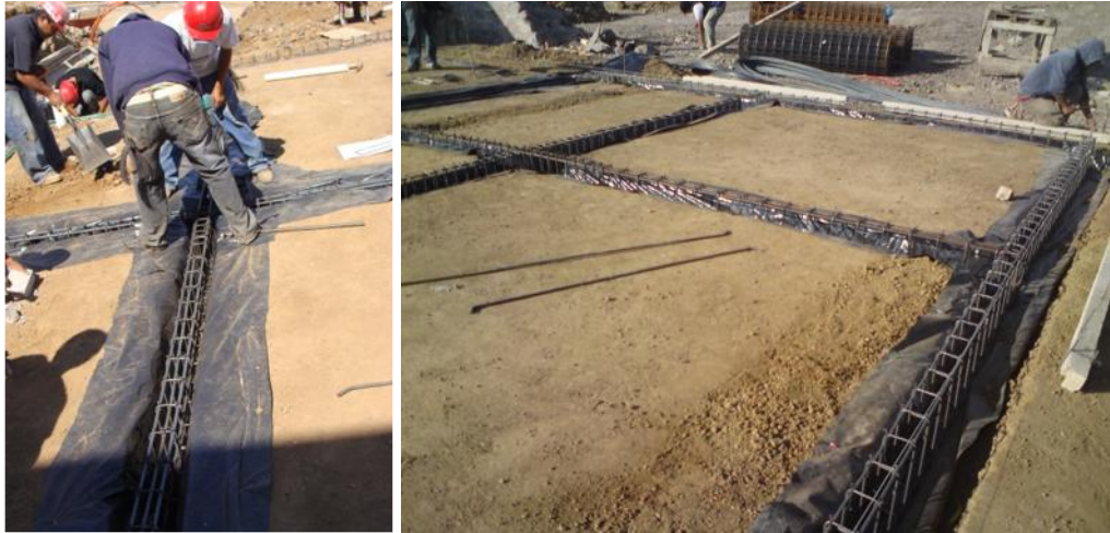
FIG. 95 y 96: ARMADO Y COLOCACIÓN DE CONTRATRABES
