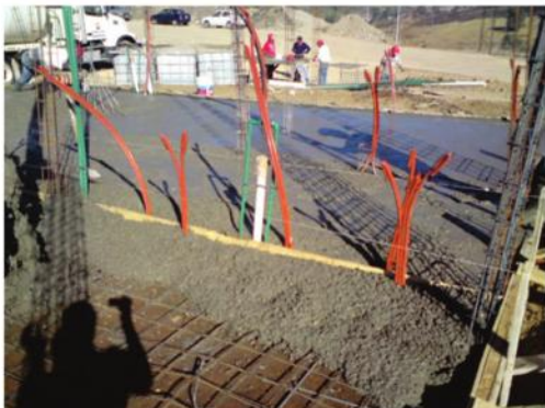
LOTE FIG.110: APLICACIÓN DE CONCRETO EN CIMENTACIÓN LOTES 21-22 (SAUCE).
