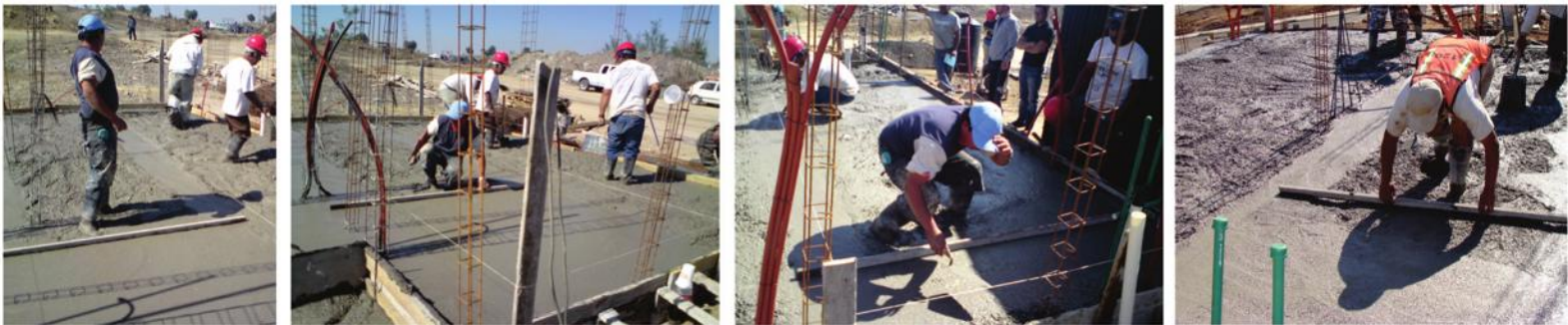
FIG. 113: SE UNIFORMIZA LA MEZCLA EN PLATAFORMAS.
