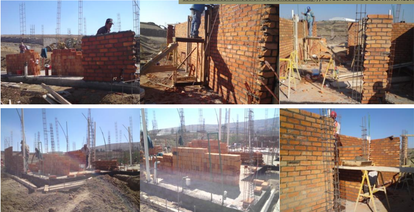
LOTE FIG. 122:CONSTRUCCIÓN DE MUROS (SAUCE) .//FOTOS: GERARDO LUDWING ACUÑA CENOZ
