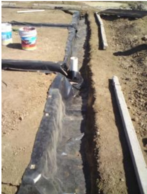
FIG. 97: MEMBRANA DE POLIETILENO (SAUCE)
