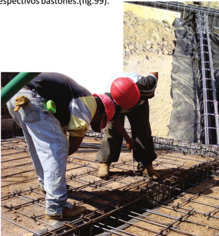
FIG. 99: COLOCACIÓN DE CONTRATRABES Y BASTONES (SAUCE) // FOTO: GERARDO LUDWING ACUÑA CENOZ
