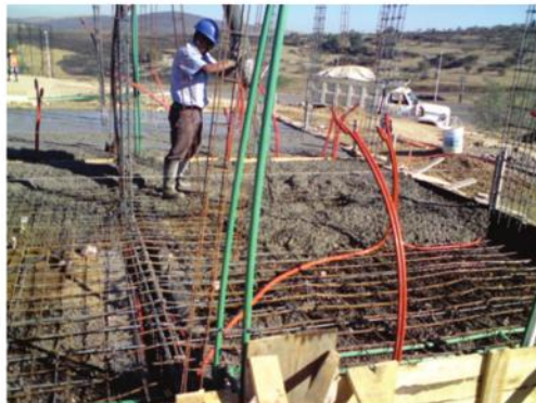
LOTE FIG.110: APLICACIÓN DE CONCRETO EN CIMENTACIÓN LOTES 21-22 (SAUCE).
