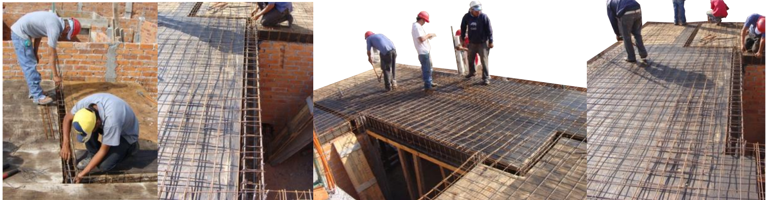
FIG. 136: COLOCACIÓN DE ACERO EN ENTREPISOS (SAUCE).
