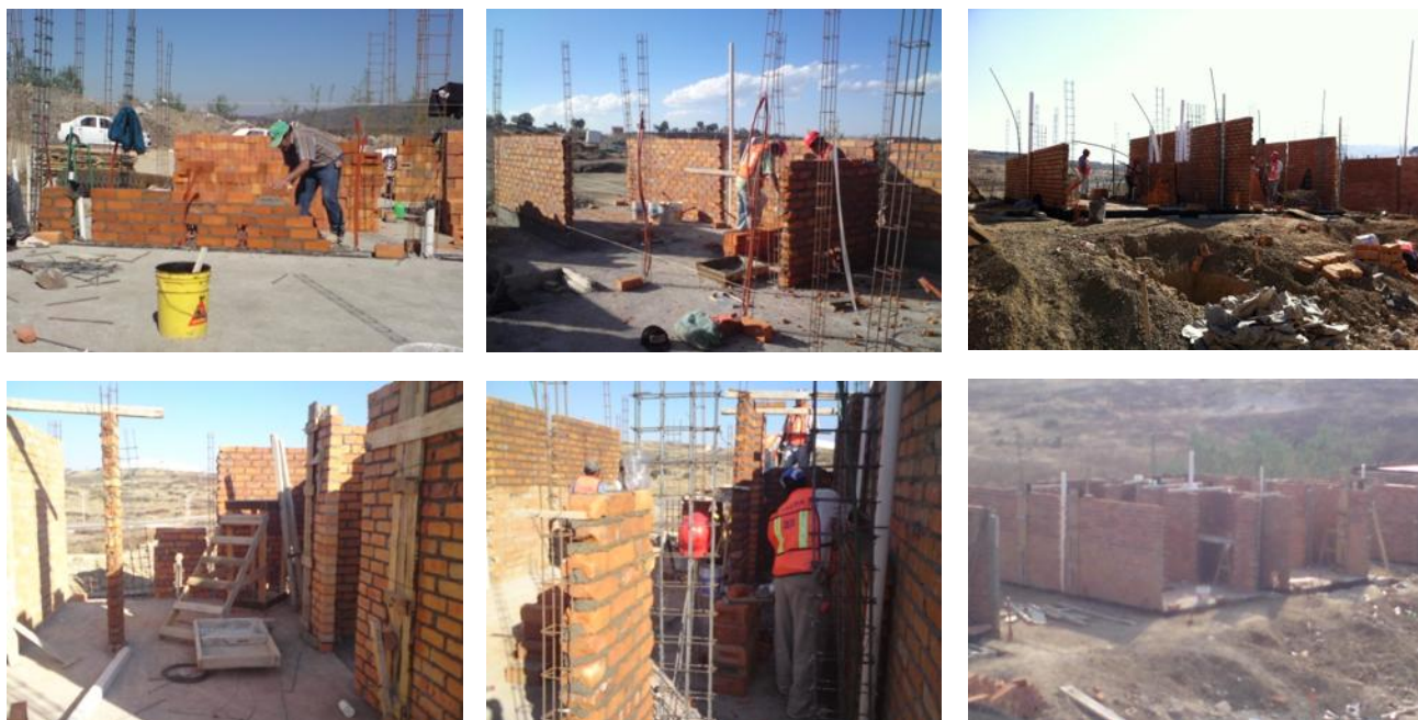
FIG. 138: CONSTRUCCIÓN DE MUROS LOTES CASTAÑO. // FOTOS: GERARDO LUDWING ACUÑA CENOZ.
