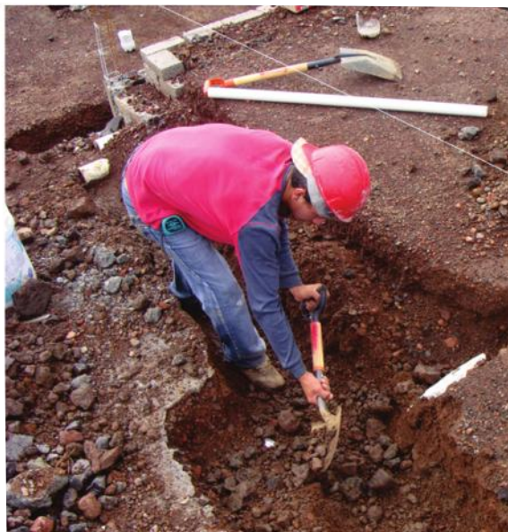
FIG. 91 - 92: EXCAVACION DE TRAZOS Y COLOCACIÓN DE TUBERIA
