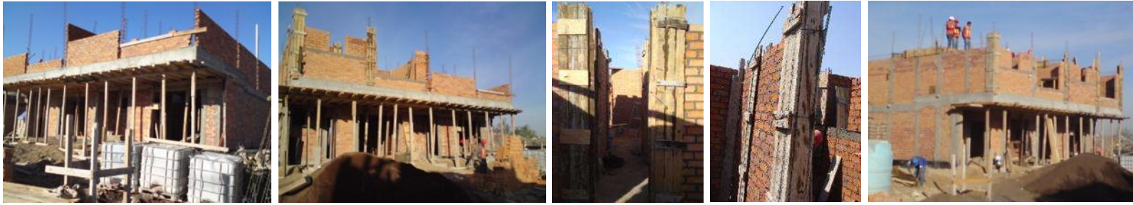
FIG. 150: CIMBRA CASTILLOS PLANTA ALTA (ROBLE).
