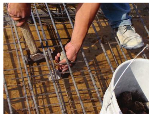
FIG. 107: CALZADO DE ARMADOS DE ACERO.
