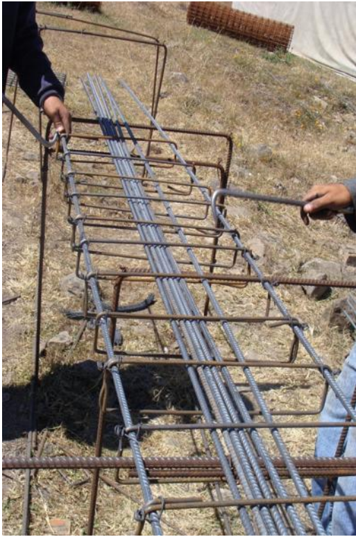
FIG. 95 y 96: ARMADO Y COLOCACIÓN DE CONTRATRABES
