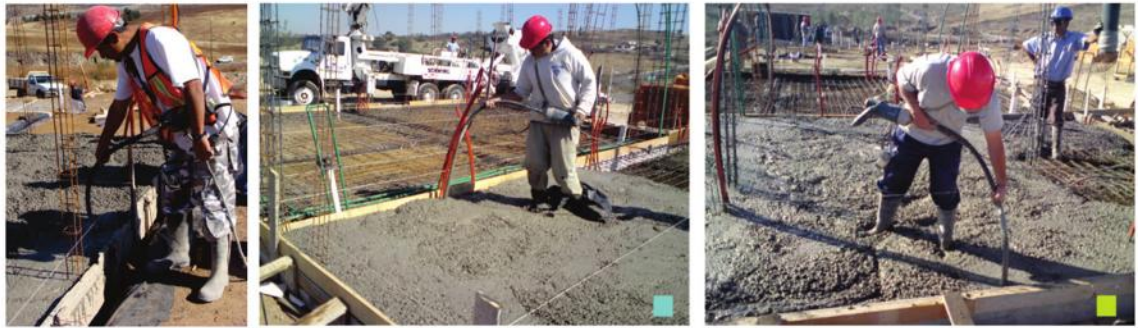
FIG. 111: VIBRADO DE ELEMENTOS ESTRUCTURALES ROBLE SAUCE.
