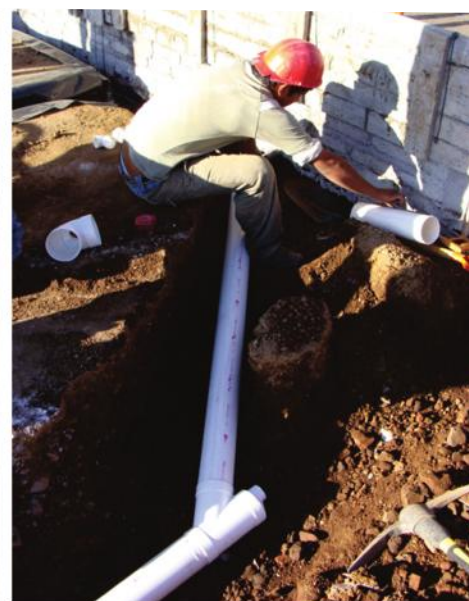
FIG. 91 - 92: EXCAVACION DE TRAZOS Y COLOCACIÓN DE TUBERIA
