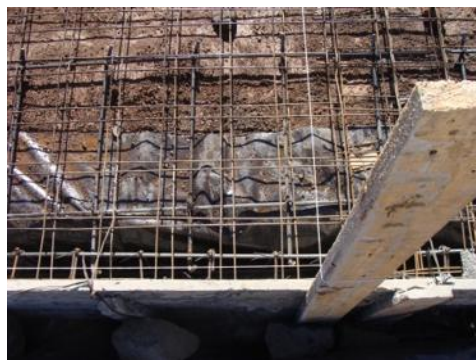
FIG. 108: COLOCACIÓN DE REVENTONES (HILOS) EN LAS PLATAFORMAS. //FOTOS: GERARDO LUDWING ACUÑA CENOZ
