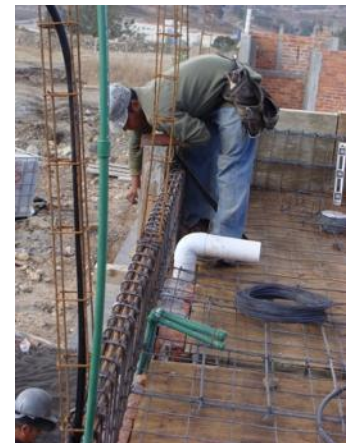
FIG. 130: INSTALACIÓN HIDRAULICA Y SANITARIA EN ENTREPISO (ROBLE).
