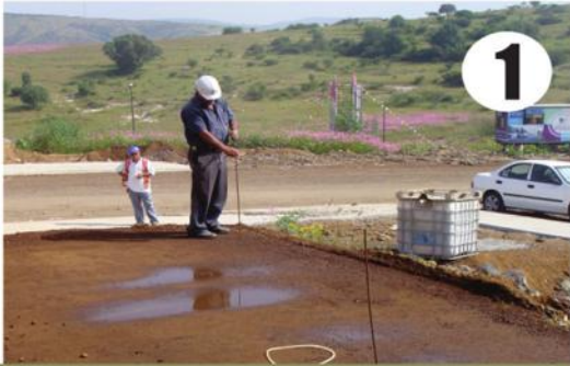
FIG. 85: SE CLAVAN VARILLAS EN LA PLATAFORMA.
