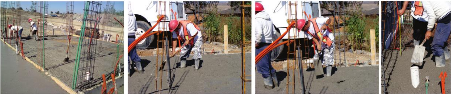
FIG. 112: APALEO DE CONCRETO.
