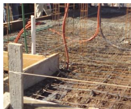
FIG. 108: COLOCACIÓN DE REVENTONES (HILOS) EN LAS PLATAFORMAS. //FOTOS: GERARDO LUDWING ACUÑA CENOZ
