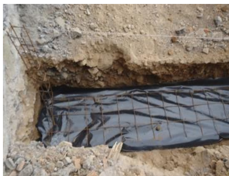
FIG. 149: ELABORACIÓN DE PLANTILLAS PARA RODAPIE EN PATIO (SAUCE).
