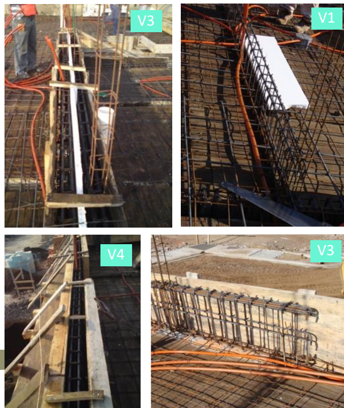
FIG. 132: VIGAS INVERTIDAS, ENCOFRADO, Y JUNTA DE POLIESTIRENO (ROBLE).
