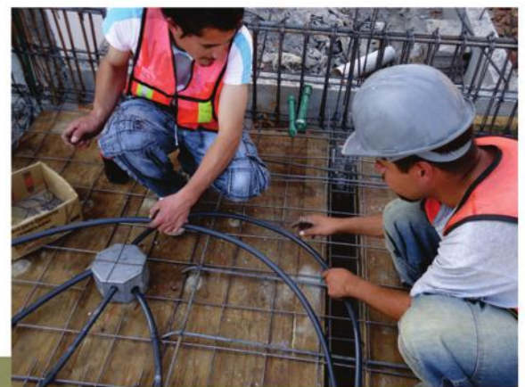
FIG. 129: COLOCACIÓN DE MANGUERA ELÉCTRICA (ROBLE) .
