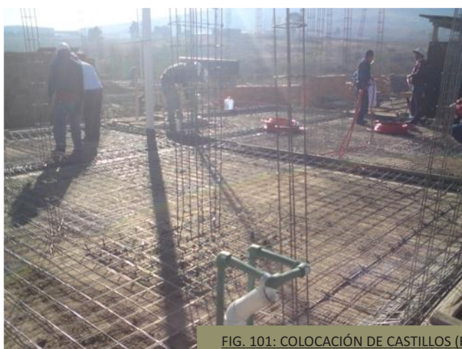
FIG. 100: COLOCACIÓN DE MALLA ELECTROSOLDADA (ROBLE)//FOTOS: GERARDO LUDWING ACUÑA CENOZ
