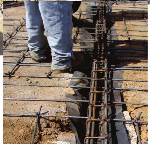
FIG. 99: COLOCACIÓN DE CONTRATRABES Y BASTONES (SAUCE) // FOTO: GERARDO LUDWING ACUÑA CENOZ
