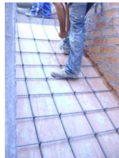
FIG. 146: CIMBRA Y ARMADO DE ESCALERAS (ROBLE).
