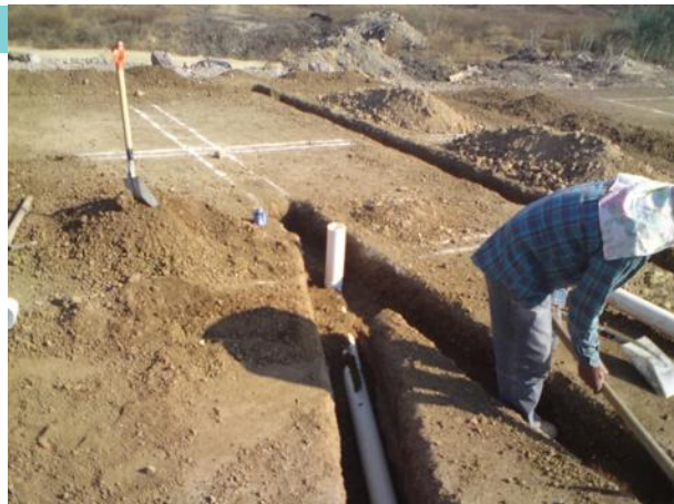
FIG. 93: COLOCACIÓN DE TUBERÍA//FOTO: GERARDO LUDWING ACUÑA
