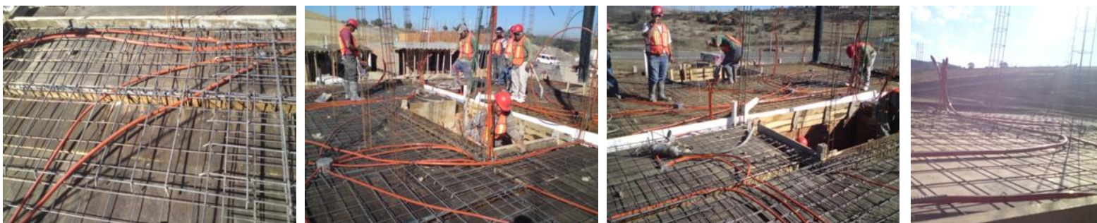
FIG. 139: COLOCACIÓN DE MANGUERA ELÉCTRICA LOTES SAUCE.
