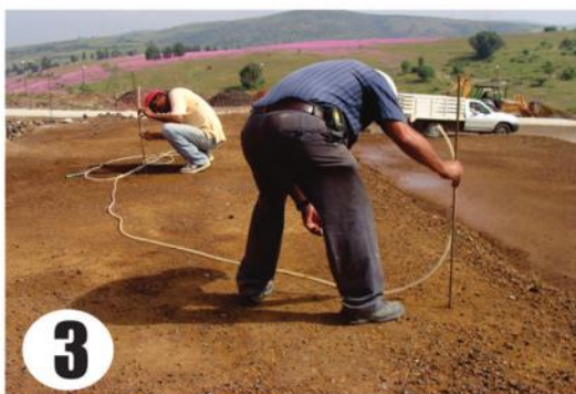
FIG. 87: SE PASA LA MEDIDA CON MANGUERA.
