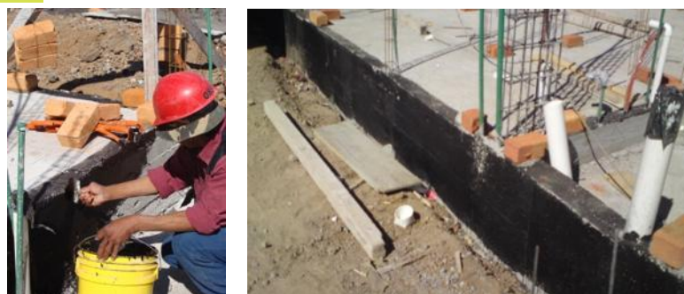
FIG. 116: IMPERMEABILIZACIÓN DE DALAS.
