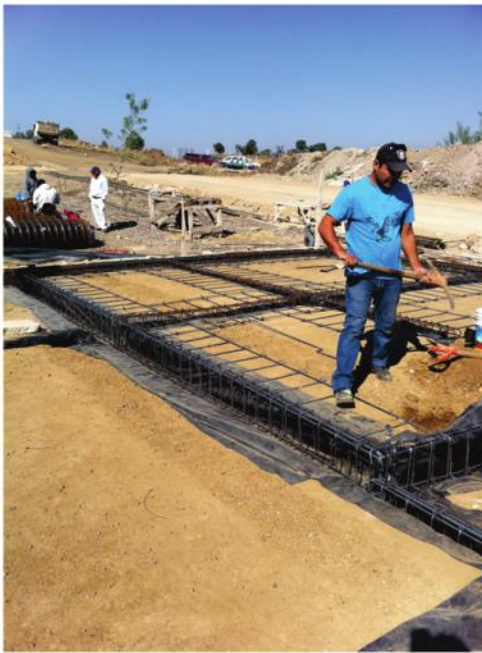
FIG. 98: FOTOS QUE MUESTRAN LA COLOCACIÓN DE LOS BASTONES
