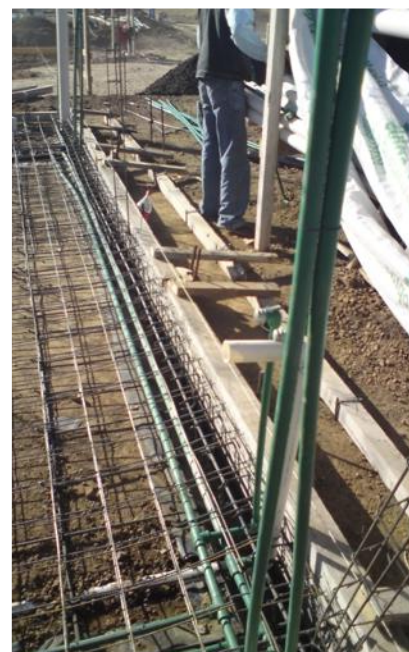
FIG. 101: COLOCACIÓN DE CASTILLOS (ROBLE)//FOTOS: GERARDO LUDWING ACUÑA CENOZ
