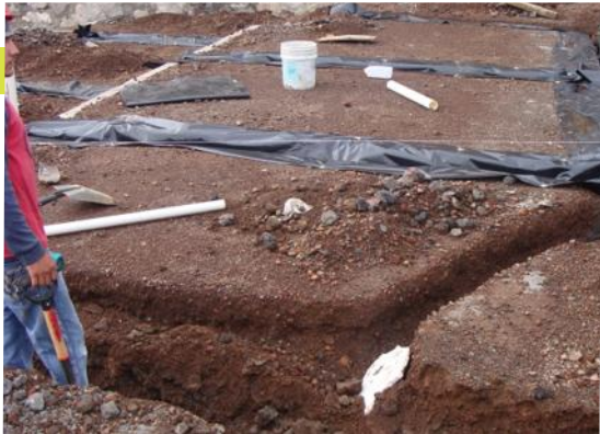
FIG. 97: MEMBRANA DE POLIETILENO (SAUCE)
