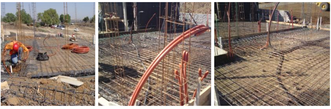
FIG. 103: COLOCACIÓN DE MANGUERA ELÉCTRICA EN LOTES ROBLE
