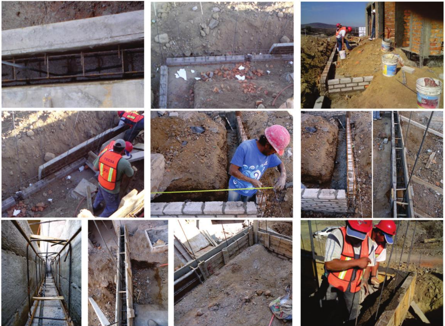
LOTE FIG. 126: PREPARACIÓN DE DALAS PARA BARDA DE BLOCK.
