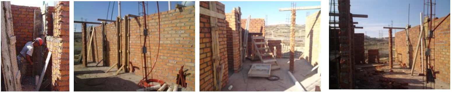
FIG. 140: CIMBRA DE CASTILLOS Y COLADO DE LOS MISMOS (CASTAÑO). // FOTOS: GERARDO LUDWING ACUÑA CENOZ.
