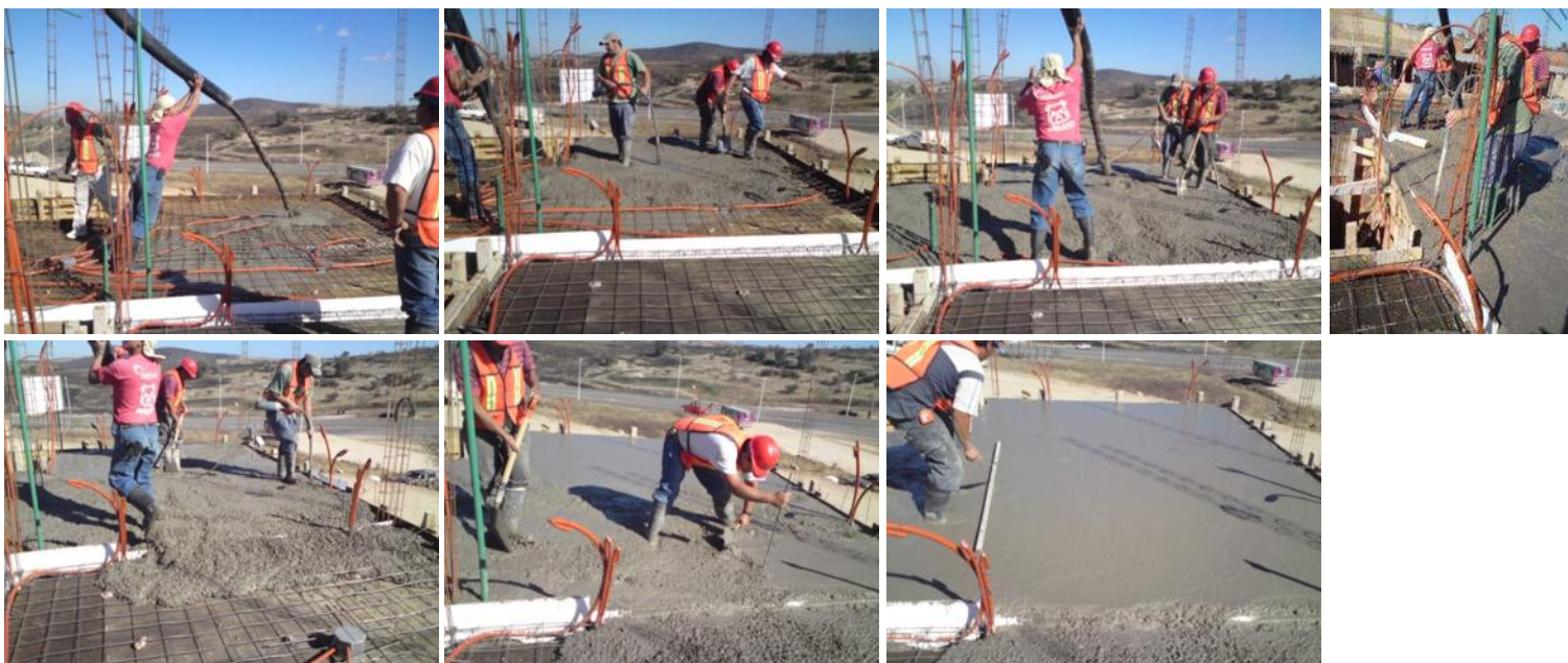
FIG. 145: COLOCACIÓN DE CONCRETO EN ENTREPISOS (SAUCE).
