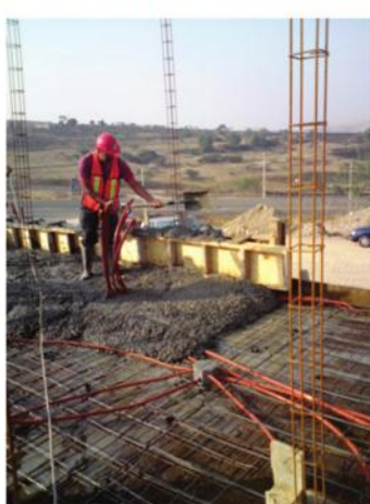
FIG. 135: VACIADO DE CONCRETO EN ENTREPISOS (ROBLE).
