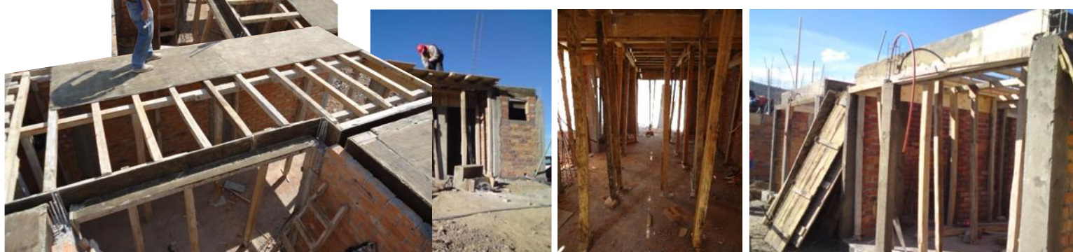
FIG. 133: CIMBRA DE ENTREPISOS (SAUCE).
