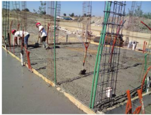
LOTE FIG.109: APLICACIÓN DE CONCRETO EN CIMENTACIÓN LOTES 1-2 (ROBLE).
