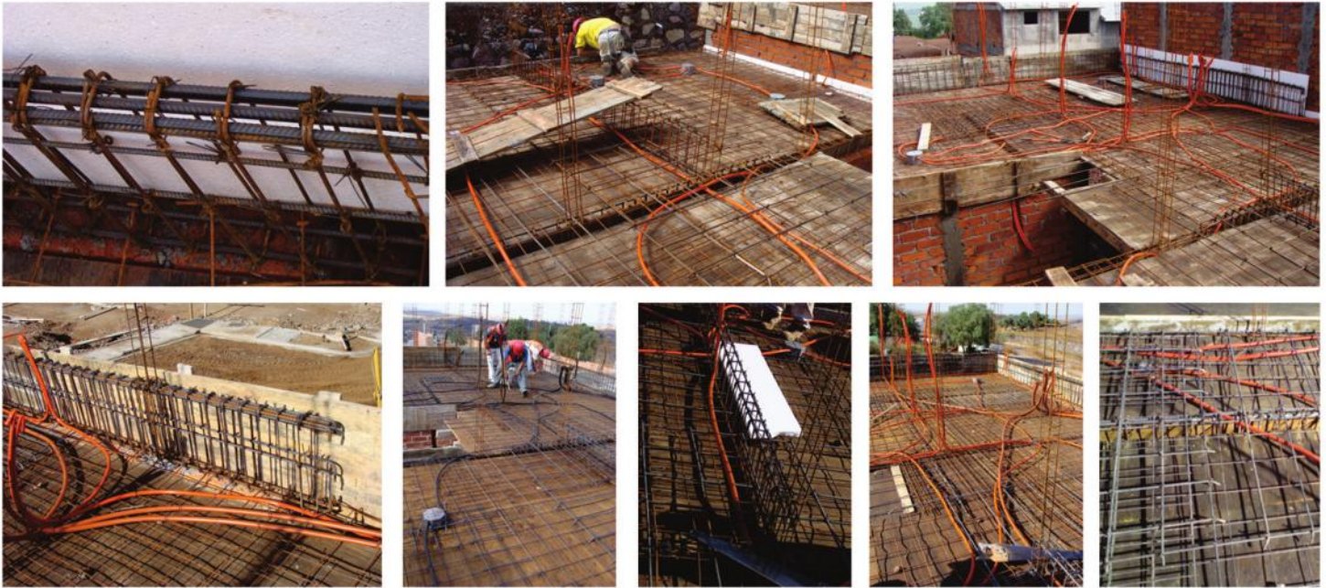
LOTE FIG. 128: COLOCACIÓN DE ACERO Y MANGUERA ELÉCTRICA (ROBLE) .
