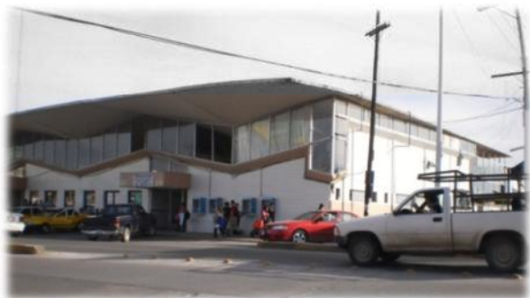
Ilustración 4. En esta foto puede verse el pandeo de la losa, además de que le faltan ya algunos vidrios en la fachada. Fotografía tomada por María Carol Ramírez Garcidueñas.
