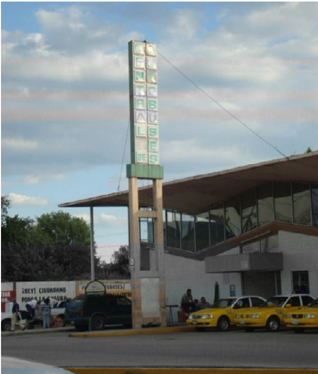
Ilustración 12. Fachada noroeste del edificio y estacionamiento. Fotografía tomada por María Carol Ramírez Garcidueñas. 26
