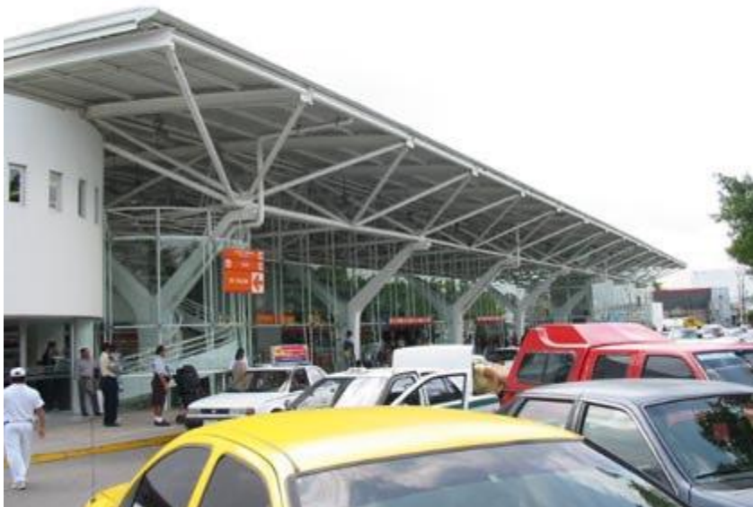
Ilustración 29. Terminal de autobuses de Cancún, México. 57
