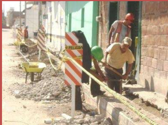
Trabajadores de la CFE excavando para alojar la tubería para la electricidad.
