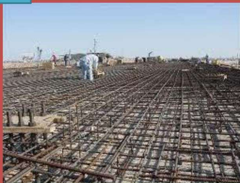
Armado de la losa maciza
