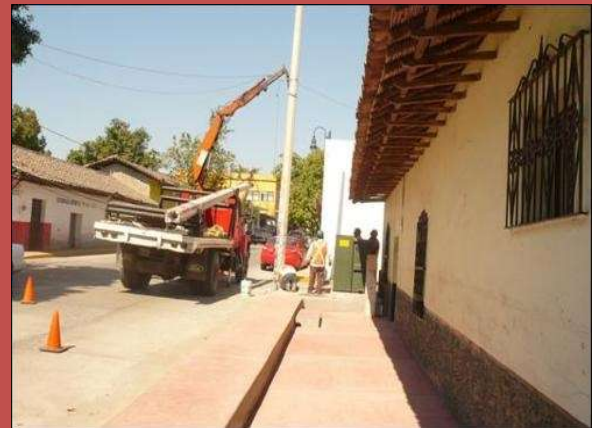
Colocando el alumbrado público.
