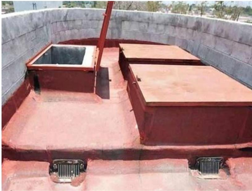
Fig. 10 Detalle del tanque para captar agua pluvial.
