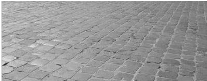
Imagen 1. Pavimentación con rocas de basalto, tomada de la página web http://www.arisac.es/adoquines.php
