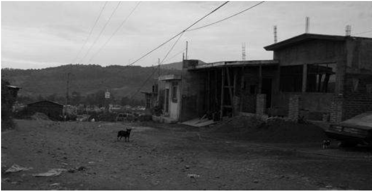
Ejemplo de vivienda en la colonia La Mesa. Se observa los materiales de construcción que se emplean en la actualidad, concreto, acero y tabique. Imagen 7. Fotografía propia de la autora, tomada el 28 de enero de 2012.
