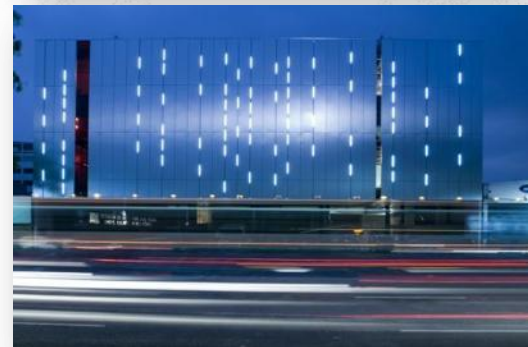
Imagen31 iluminación de la fachada principal
