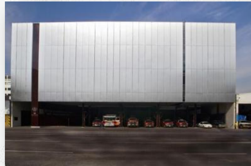
Imagen30 Fachada principal de la estación de Ave Fénix
