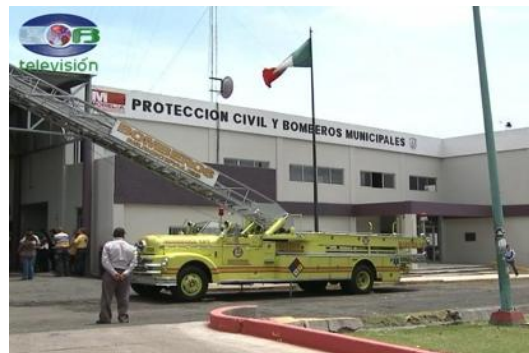
Imagen28 Fachada de Protección Civil y Bomberos Municipales de Morelia, MANAVION; Septiembre, 2011.
