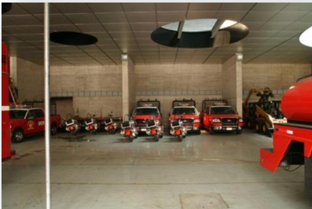
Imagen33 Fotografía de la parte del estacionamiento.
