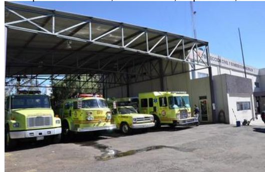
Imagen29 Estacionamiento, Protección Civil y Bomberos Municipales de Morelia, MANAVION; Septiembre, 2011.
