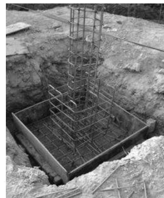
Imagen 40 zapata aislada
