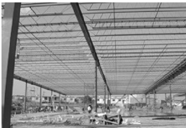
Imagen 36 losaacero sistema de cubierta ligera
