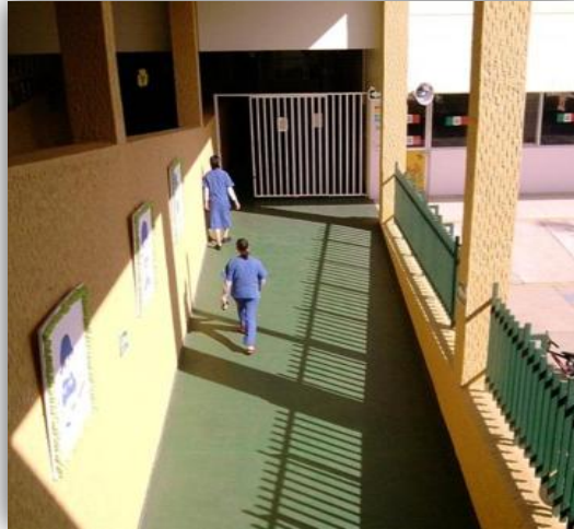
Foto 15: Distancia entre columnas de la Guardería. ACSU Foto tomada por: Luis Enrique Ruiz.
