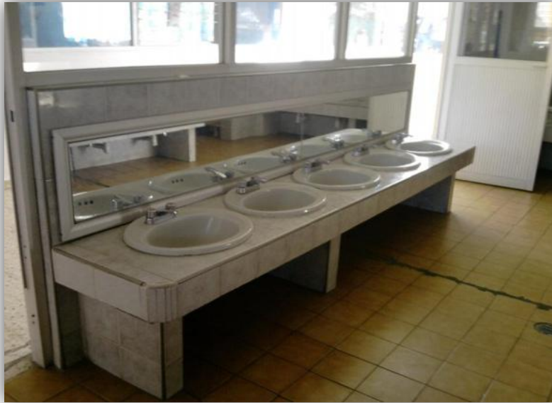
Foto 25: Sanitarios. Foto tomada por: Luis Enrique Ruiz.
