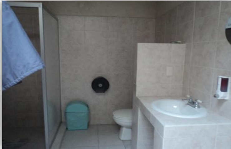
Fotos 44: Sanitarios Empleados: Foto tomada por: Aldo Miranda
