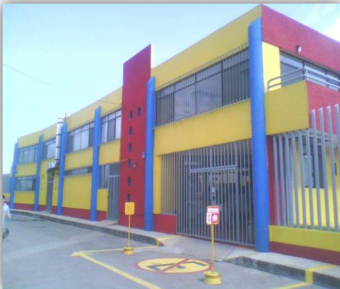
Foto 6: Fachada 1. Foto tomada por A.K.M.E.
