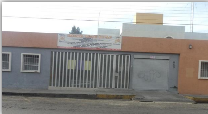
Foto 26: Fachada Guardería Sol. Foto tomada por: Luis Enrique Ruiz.
