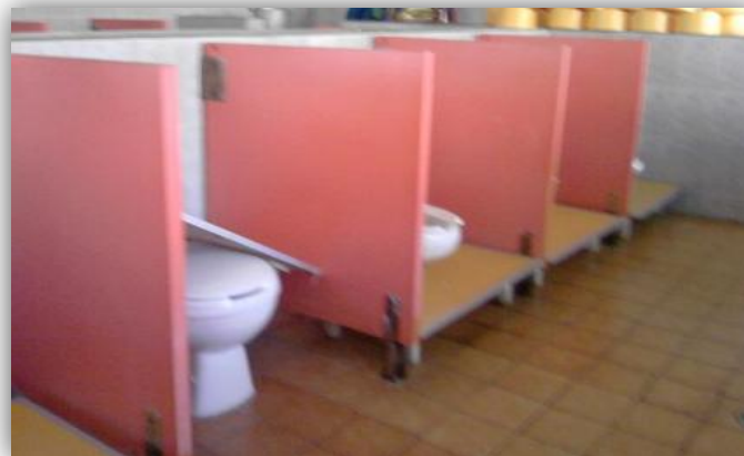
Foto 26: Sanitarios. Foto tomada por: Luis Enrique Ruiz.
