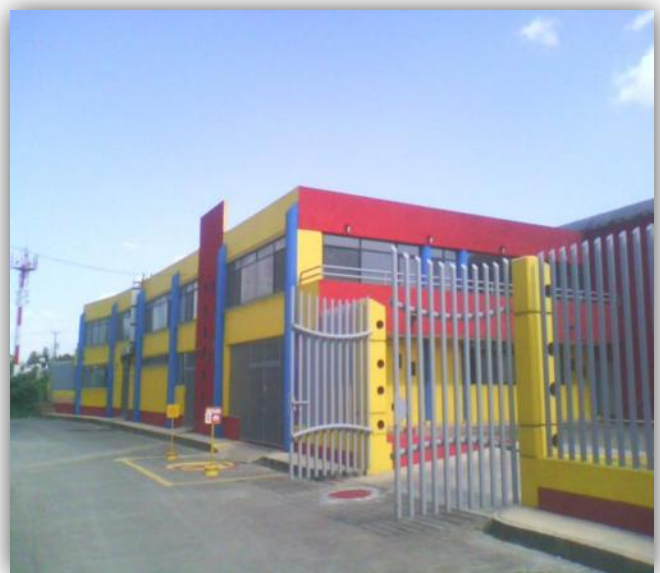
Foto7: Fachada 2. Foto tomada por A.K.M.E.
