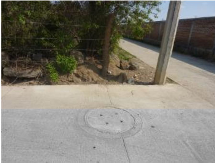
Foto 8. Foto de Pavimentos y Pozo de Visitas.
