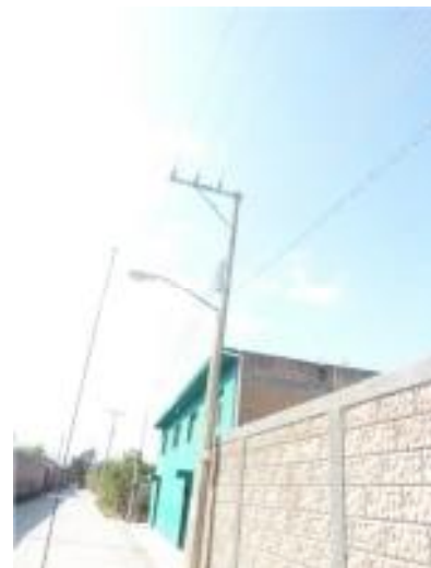
Foto 10. Foto de electrificación.
