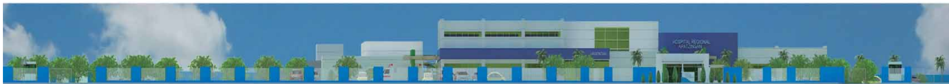
FACHADA PRINCIPAL EXTERIOR - AVENIDA FRANCISCO I. MADERO (NOROESTE)
