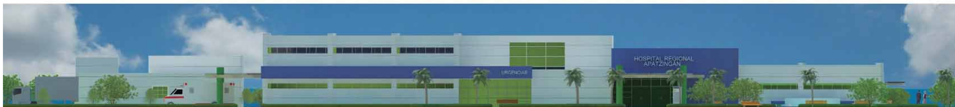
FACHADA PRINCIPAL INTERIOR - AVENIDA FRANCISCO I. MADERO (NOROESTE)
