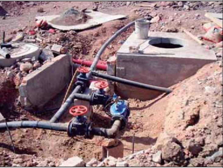
CUADRO DE DISTRIBUCIÓN DE LÍNEAS
