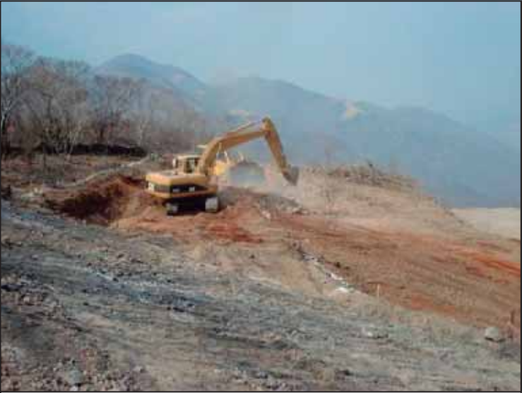
PERFILADO DE TALUDES
