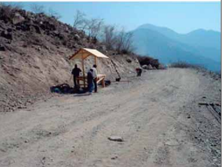
VISTA 5.- VIALIDAD DE DORMITORIOS
