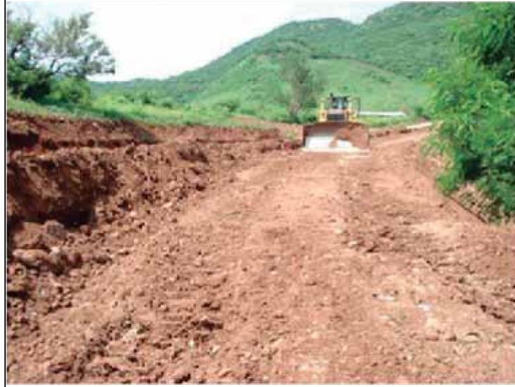
VISTA 3.- APERTURA DE VIALIDADES
