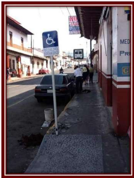
Foto 24: Banquetas de concreto y rampas para discapacitados existentes.
