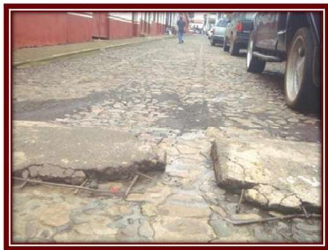
Foto 25: Empedrado del arroyo vehicular de la calle Guerrero.
