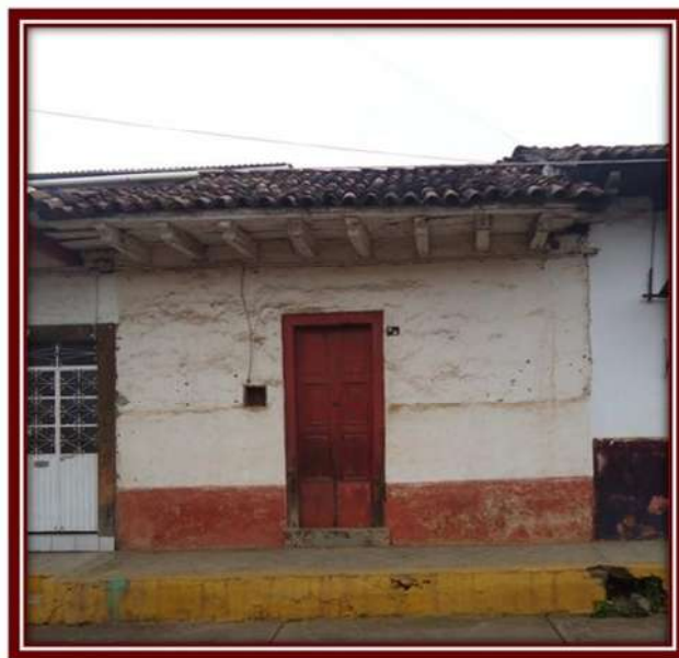
Foto 07: Fachada exterior con un solo vano que consiste en una puerta de acceso.
